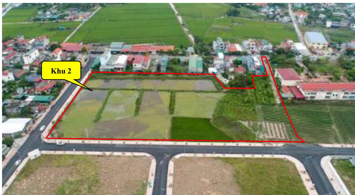
Hình 8. Hiện trạng khu 2 – dự án KDC An Đồng II trên thực tế
