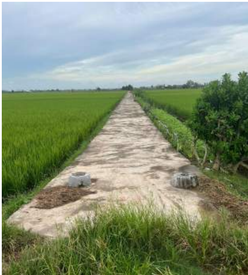
Hình 16. Hiện trạng tuyến đường bê tông nằm trong khu 1 của dự án
