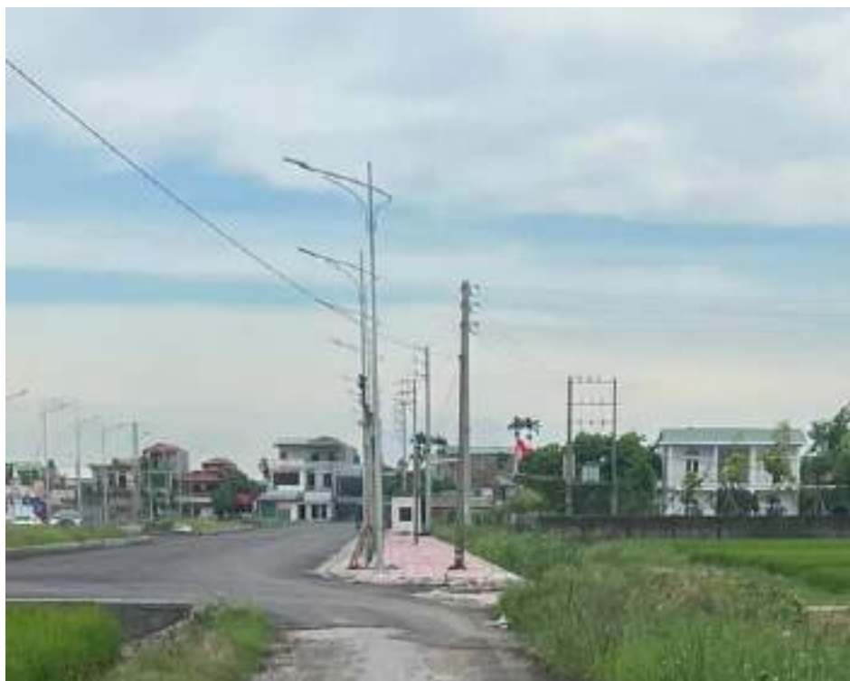
Hình 12. Tuyến đường dây điện 22kV tiếp giáp dự án
