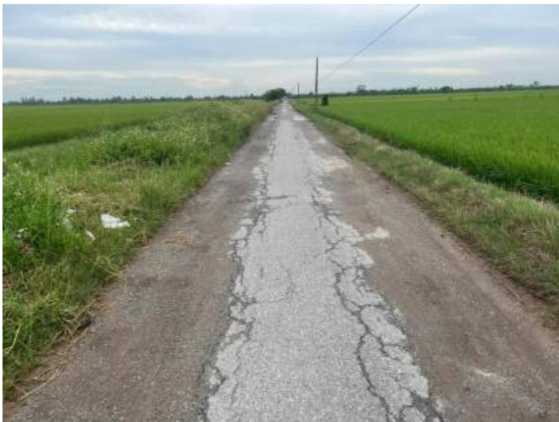
Hình 14. Hiện trạng tuyến đường bê tông chạy qua khu 1 dự án
