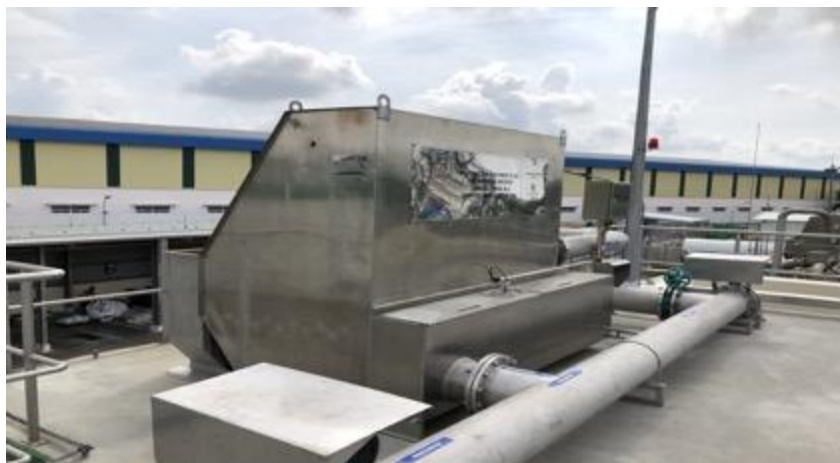
Hình 3. 27: Hình ảnh minh họa thiết bị lược rác tinh
