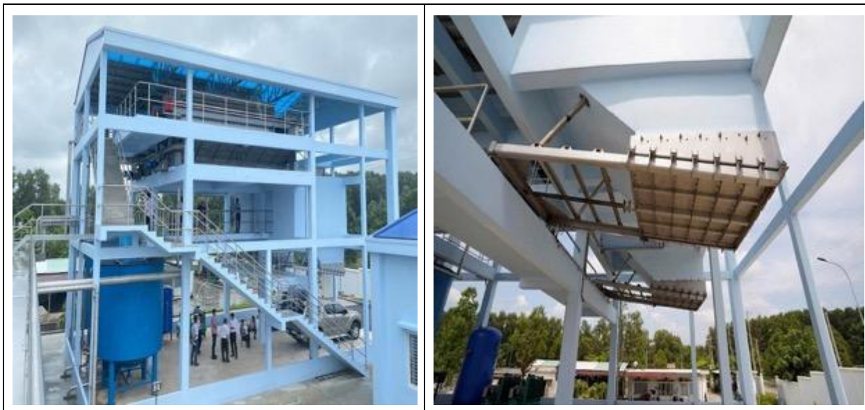
Hình 3. 31: Hình ảnh minh họa máy ép bùn và phễu chứa bùn
