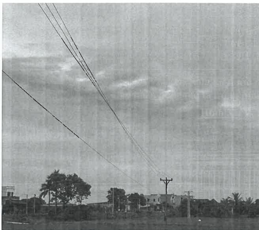
Hình 34. Hiện trạng đường điện chạy qua dự án
