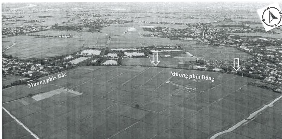
Hình 20. Kênh mương phía Đông dự án
