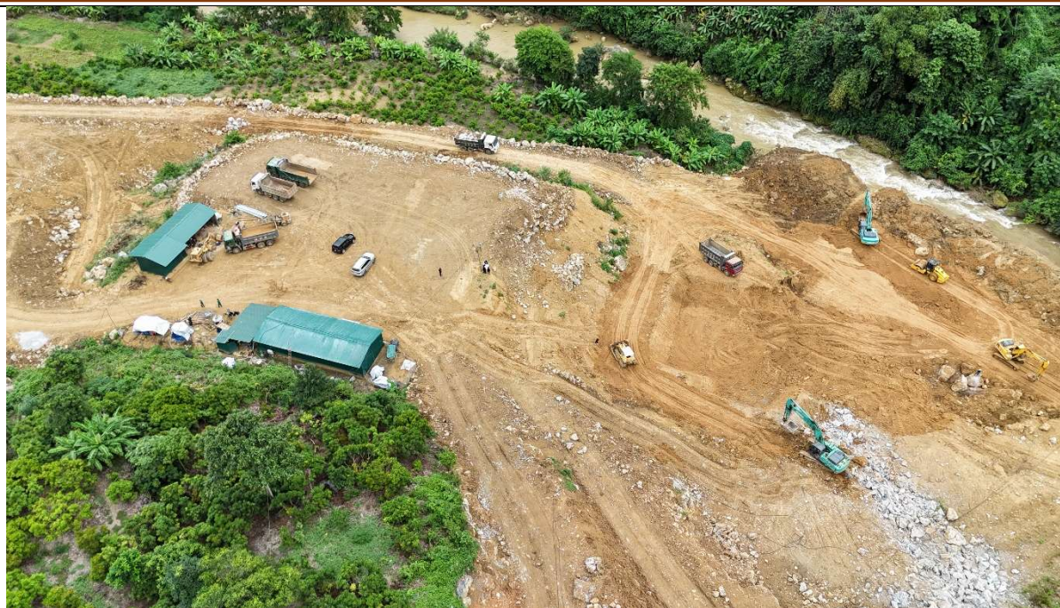
Khu vực xây dựng nhà máy
