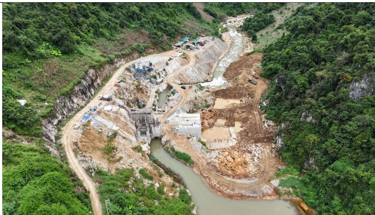
Khu vực xây dựng tuyến đập
