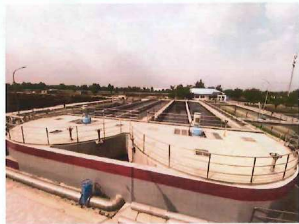
Hệ thống cấp khí bề mặt và bể Anoxic - Oxic
