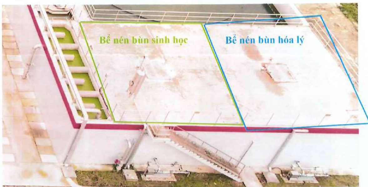
Hình 3. 21. Bể nén bùn sinh học và bể nén bùn hóa lý
