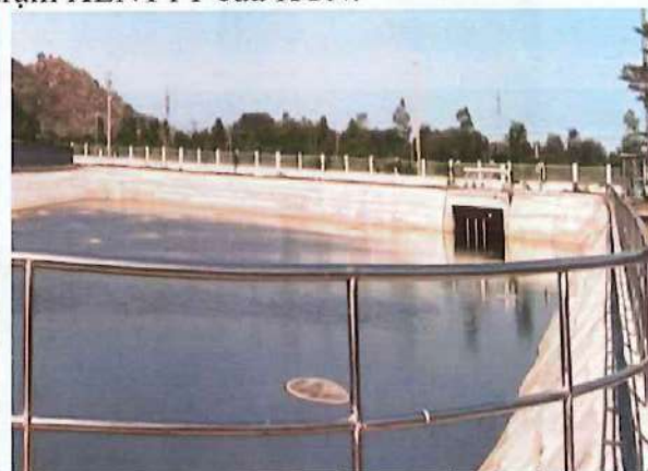
Hồ bơm và bơm lắp tại hồ sơ cố 2
