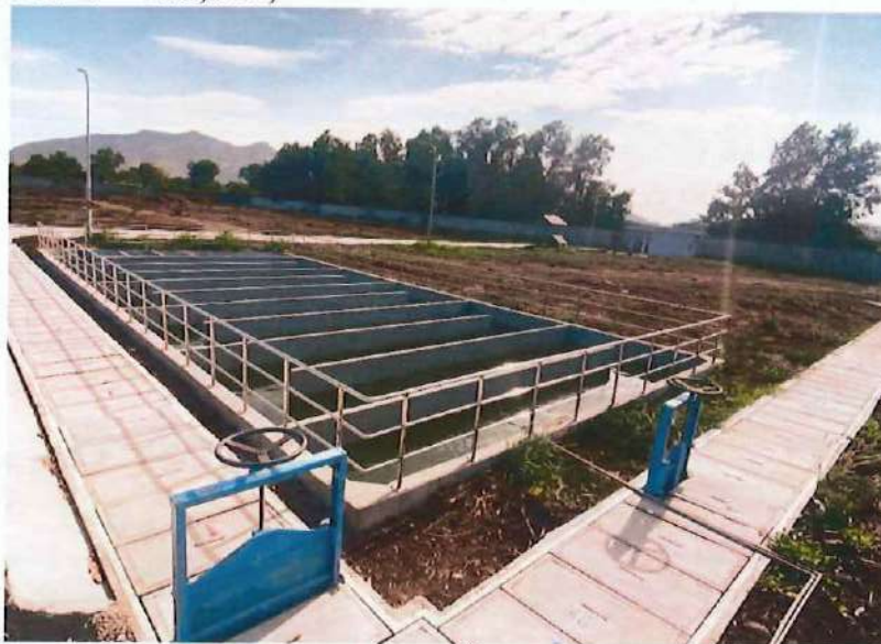
Hình 3. 20. Bể khử trùng
