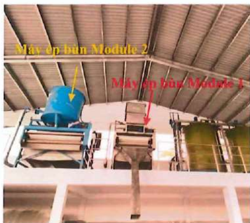
Hình 3. 33. Nhà ép bùn Trạm XLNTTT số 02
