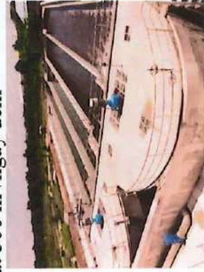
Hình ảnh cụm bể module 2 công suất 4.000 m 3 /ngày.đêm
