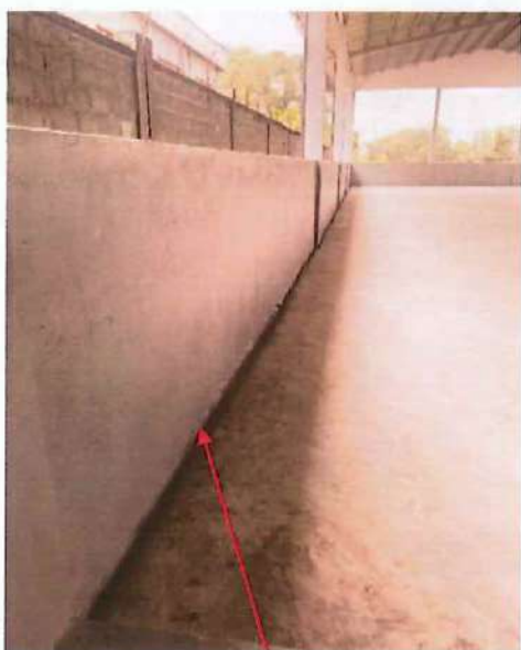
Rãnh thu gom nước thải bên trong nhà ép bùn dẫn về hố thu Trạm XLNTTT số 2
