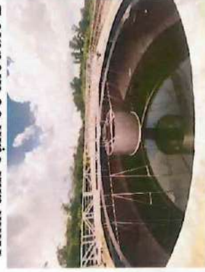
Hình ảnh cụm bể module 3 công suất 8.000 m 3 /ngày.đêm
