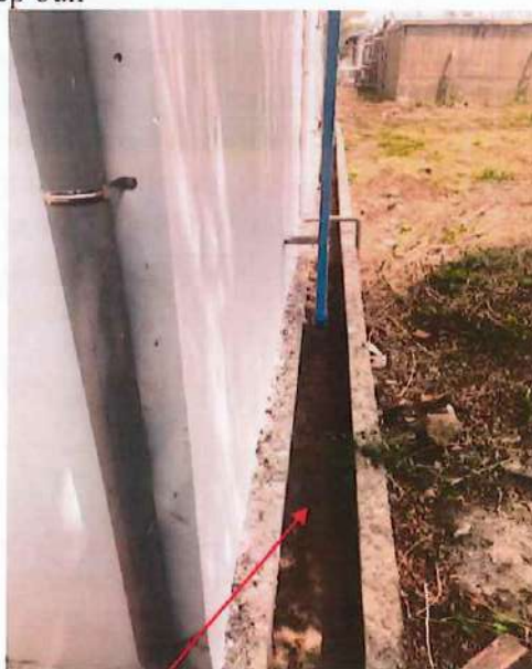
Rãnh thu gom nước thải bên ngoài nhà ép bùn dẫn về hố thu Trạm XLNTTT số 2
