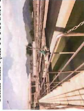
Hình ảnh cụm bể module 2 công suất 4.000 m 3 /ngày.đêm
