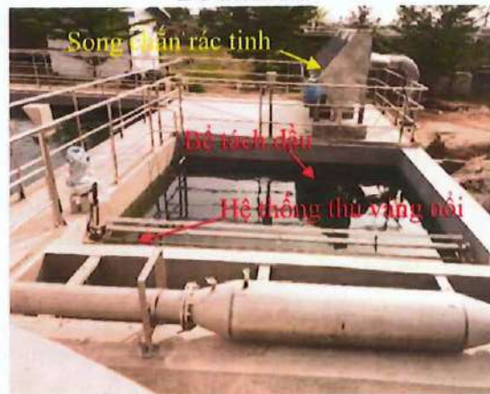
Bể tách dầu và hệ thống thu vớt nổi
