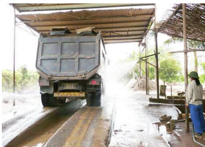
Hình 1. Phun rửa bánh xe tại dự án
