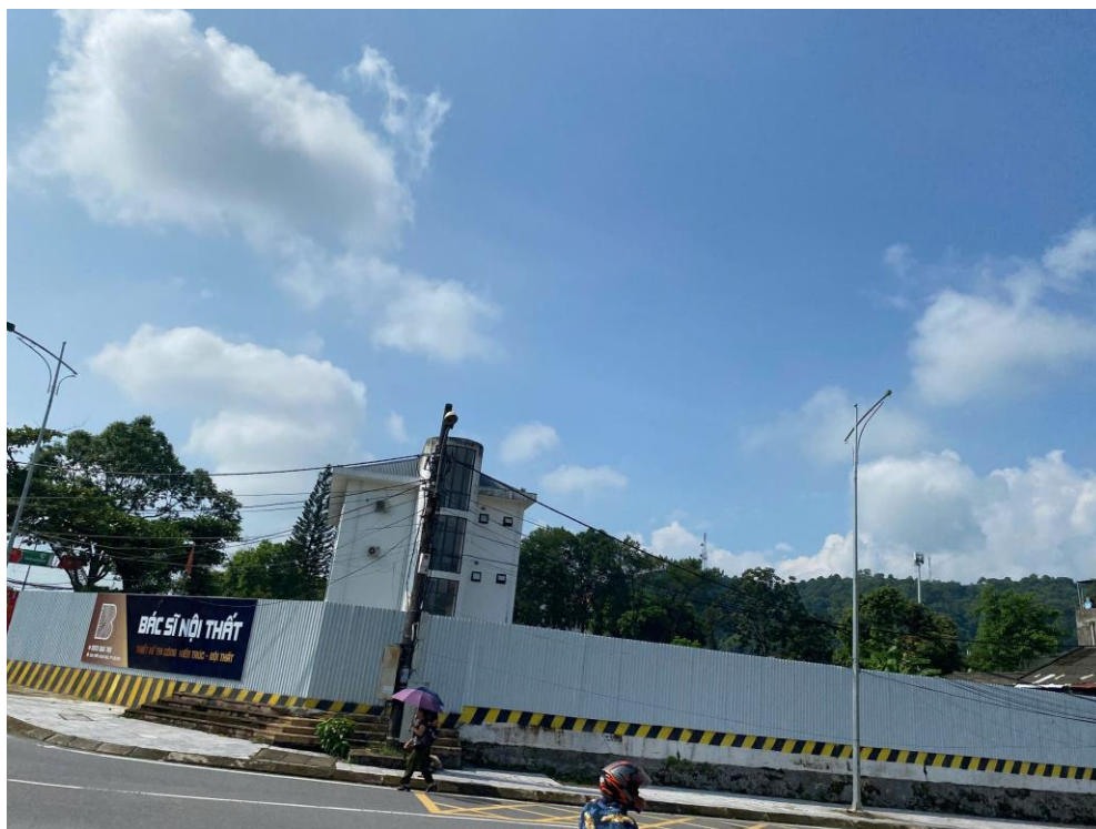
Hình 8: Lắp đặt rào tôn xung quanh dự án
