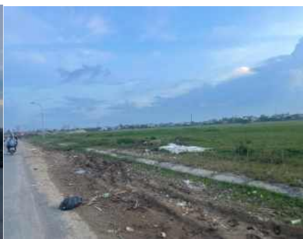
Hiện trạng khu đất giai đoạn 1
