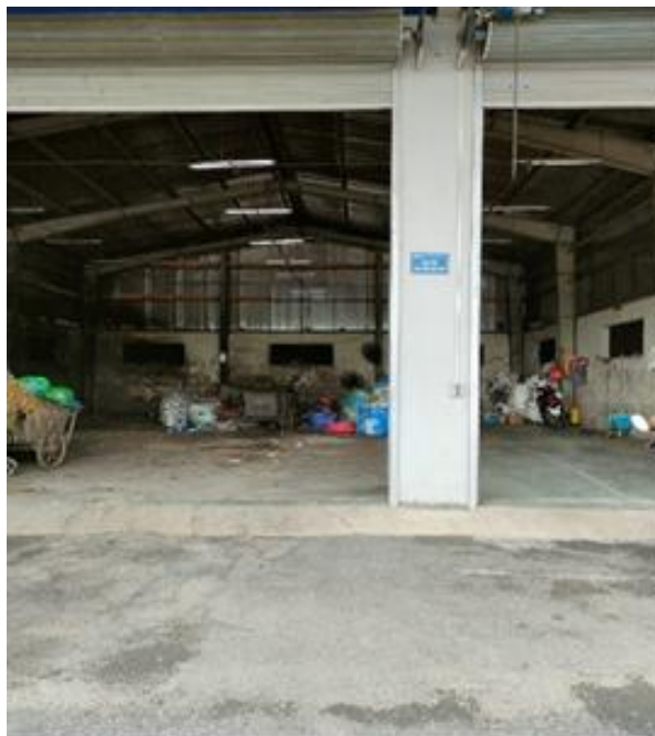
Hình 21: Nhà chứa chất thải rắn thông thường tại Trạm trung chuyển chất thải Nội Bài
