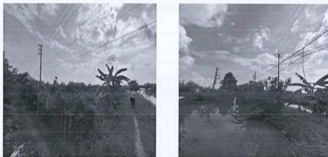
Hình 1. 4. Tuyến đường điện chạy trong ranh giới dự án
