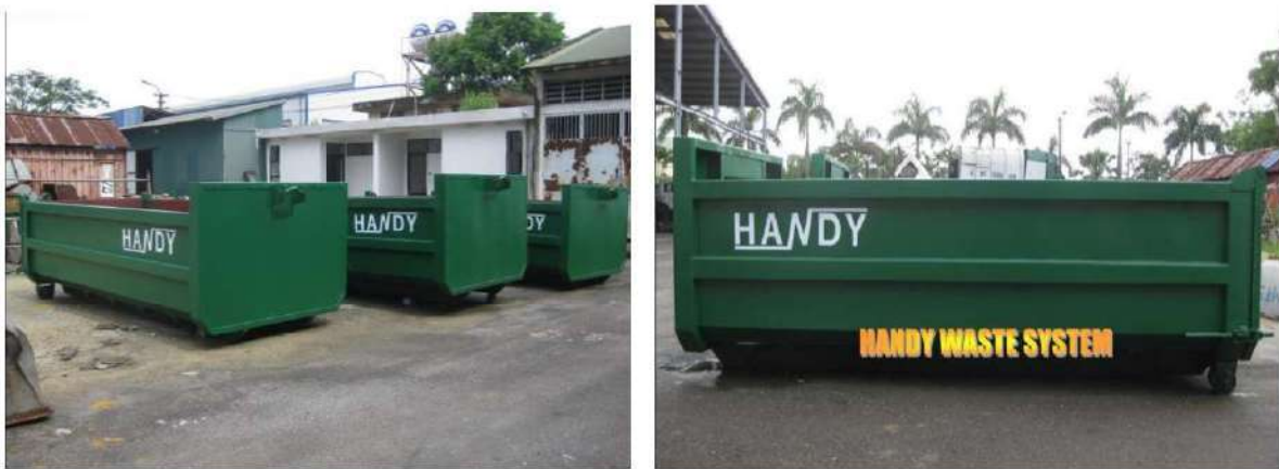
Hình 3. 3. Hình ảnh thùng ben chứa phế thải xây dựng tại công trường thi công dự án
