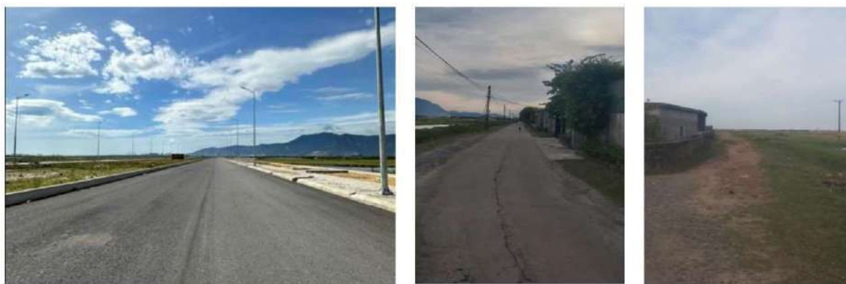
Hình 1. 4. Hiện trạng các tuyến đường giao thông khu vực dự án
