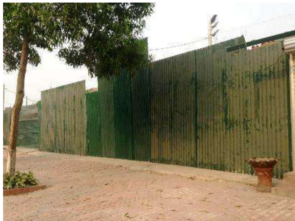
Hình 1.16. Biện pháp che chắn công trình
