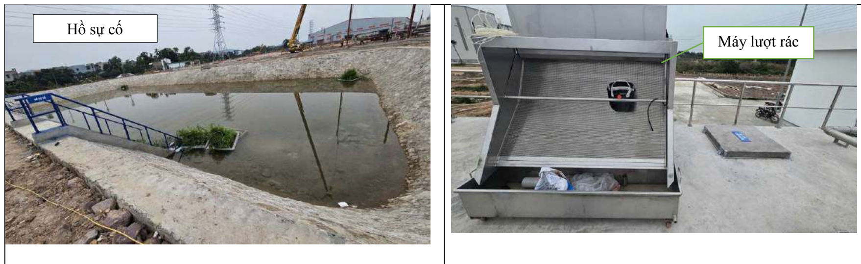
Hình 3.9. Một số hình ảnh Trạm XLNT tập trung của dự án
