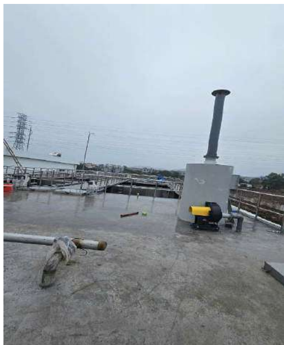
Hình 3.14-Tháp xử lý mùi và cơ chế hoạt động
