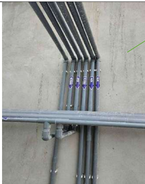
Đường ống dẫn hóa chất, dinh
