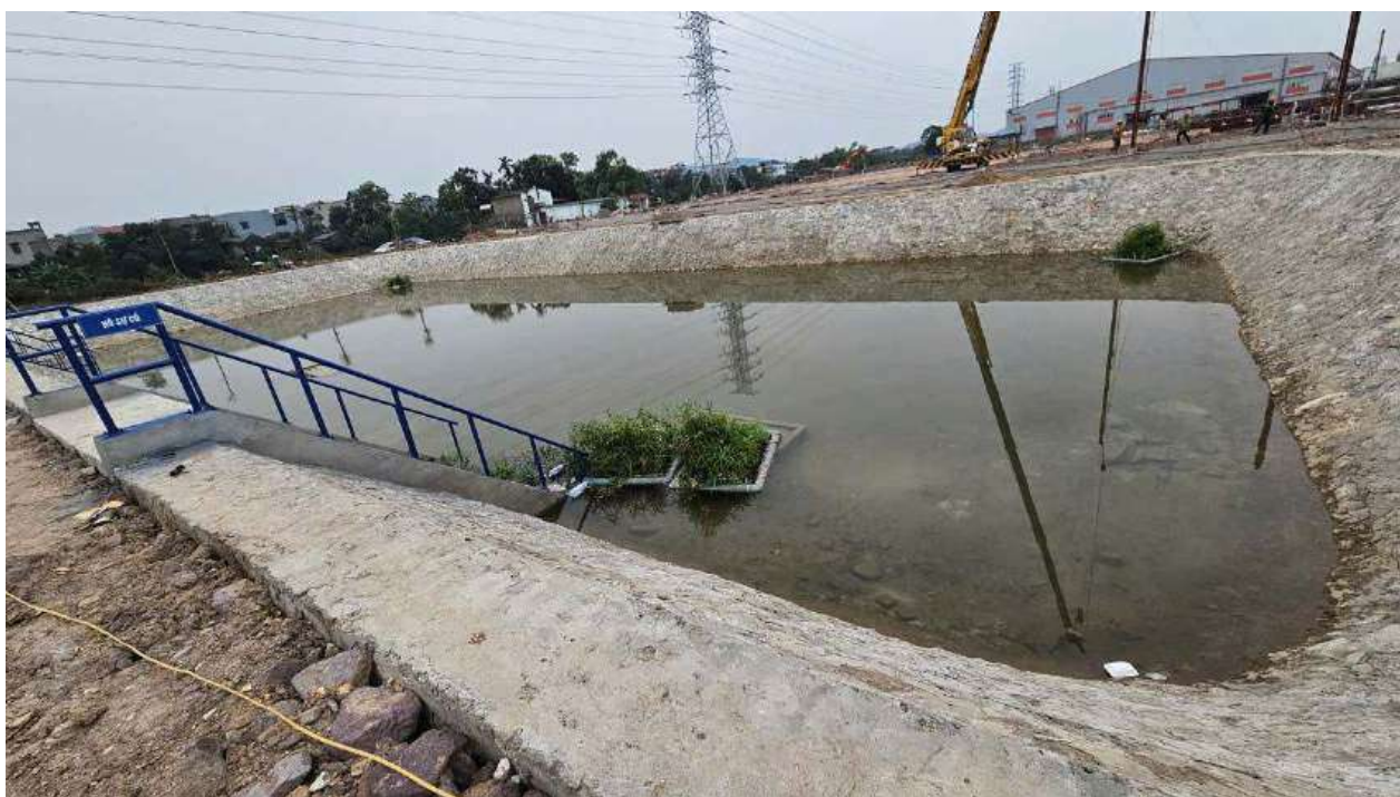
Hình 3.17. Hình ảnh hồ sự cố hoàn thiện của dự án
