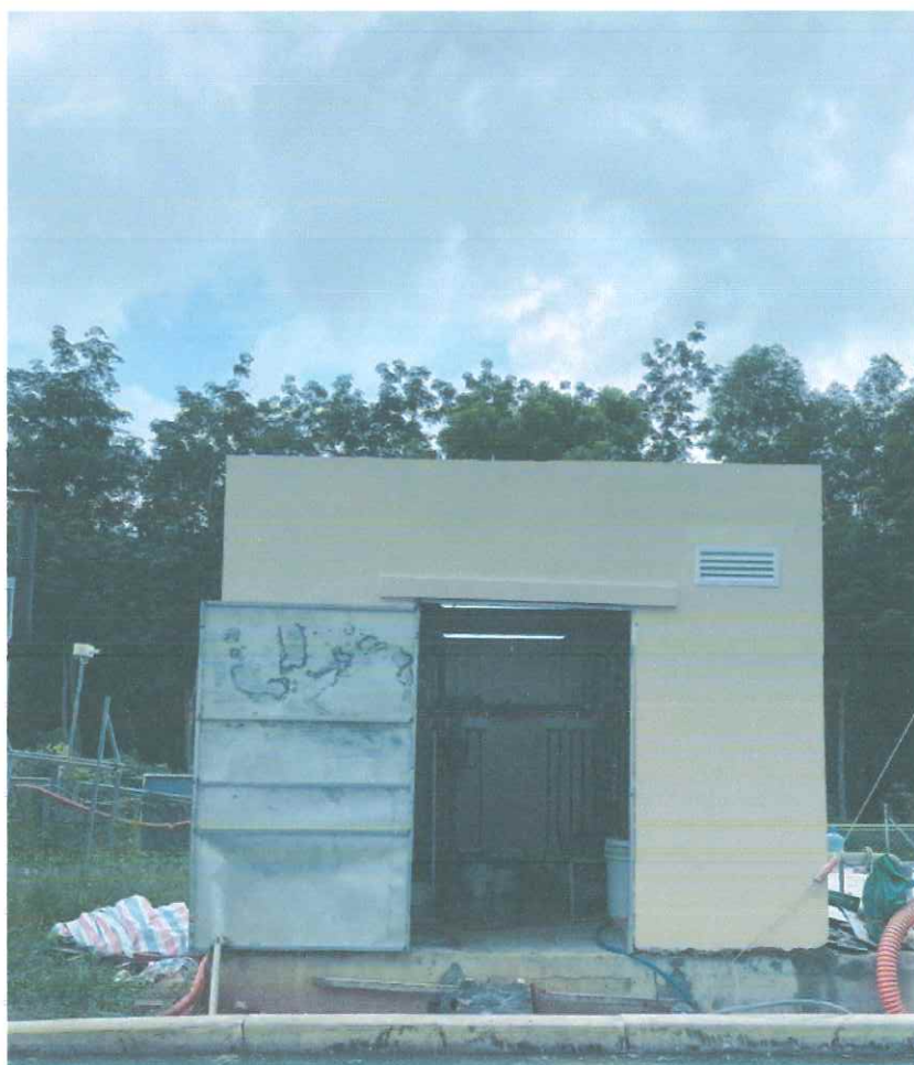
Hình 1. 14. Hệ thống xử lý nước cấp
