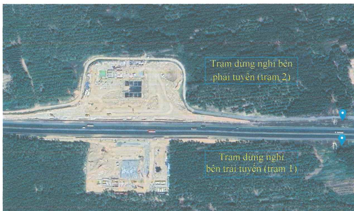
Hình 3. 1. Vị trí xả nước mưa của dự án
