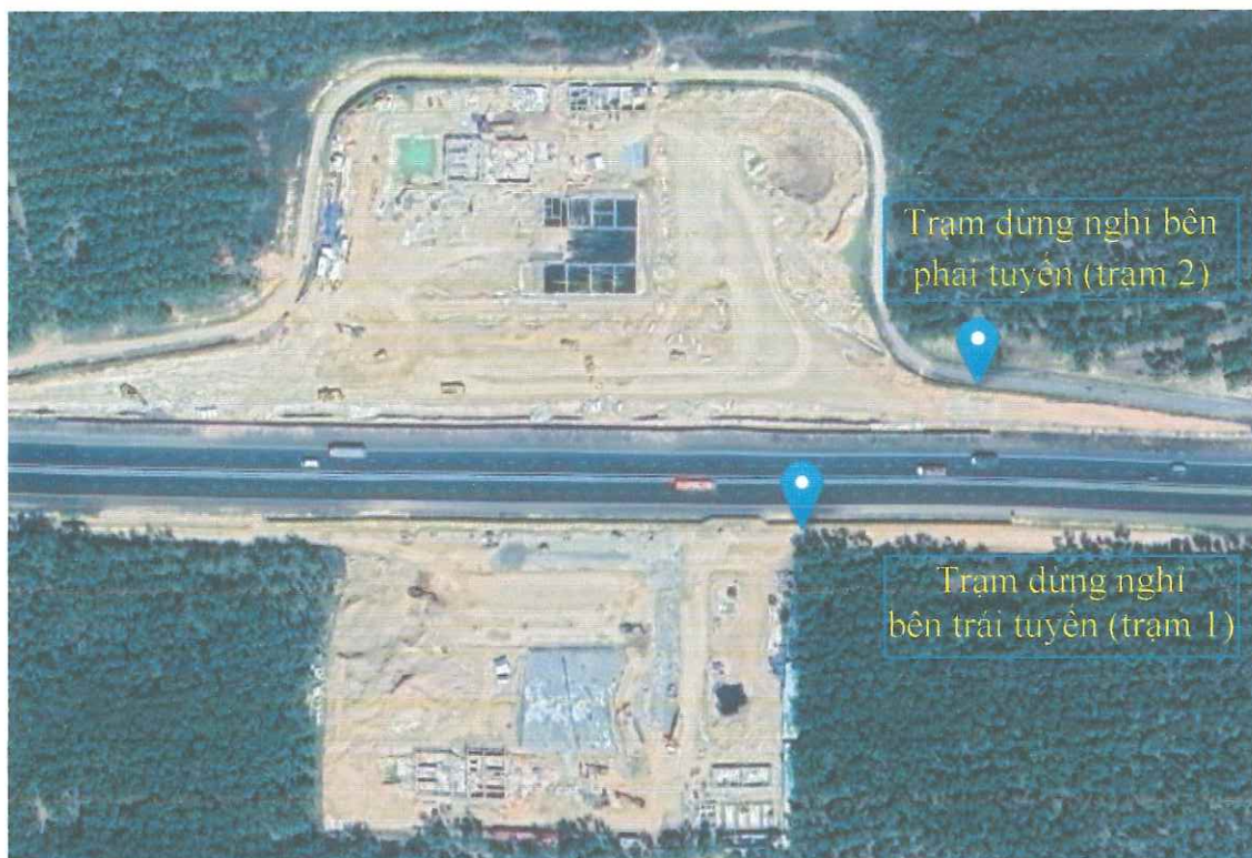
Hình 3. 20. Vị trí đầu nối nước thải sau hệ thống xử lý nước thải tập trung
