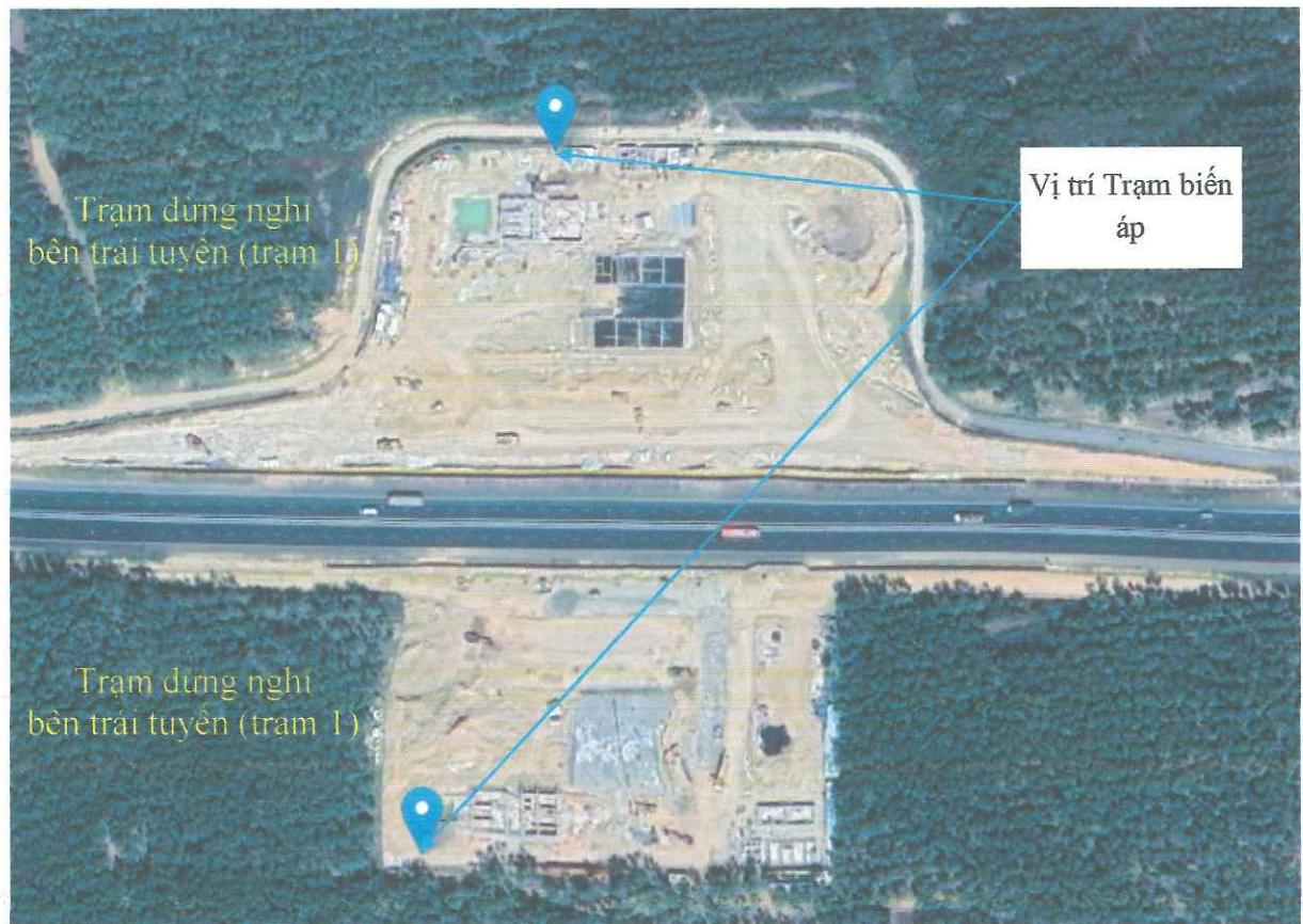
Hình 1. 19. Vị trí Trạm biến áp tại dự án
