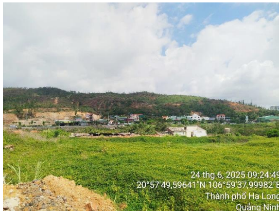
Hình 1.4: Khu vực trung tâm Dự án
