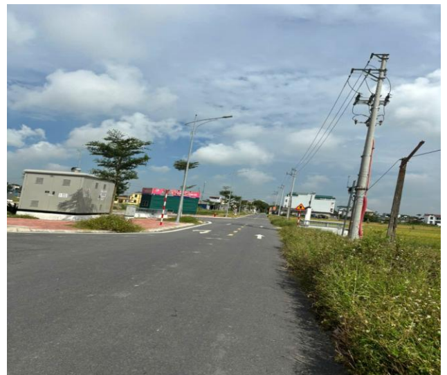
Hình ảnh hệ thống điện chiếu sáng và điện sinh hoạt đã lắp đặt
