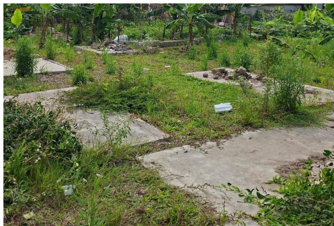
Hình ảnh bể xử lý nước thải
