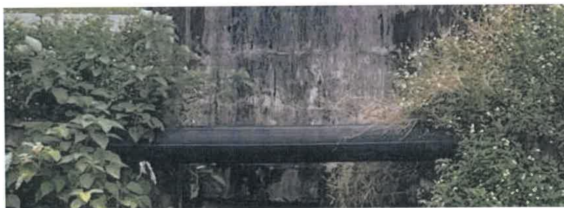
Hình 12. Tuyến ống cấp nước DN160 hiện trạng chạy qua khu vực dự án
