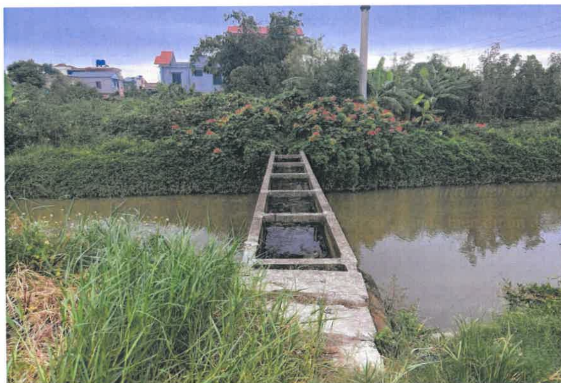
Hình 9. Hiện trạng thoát nước tập trung của các khu vực xung quanh về tuyến kênh Hải Vân
