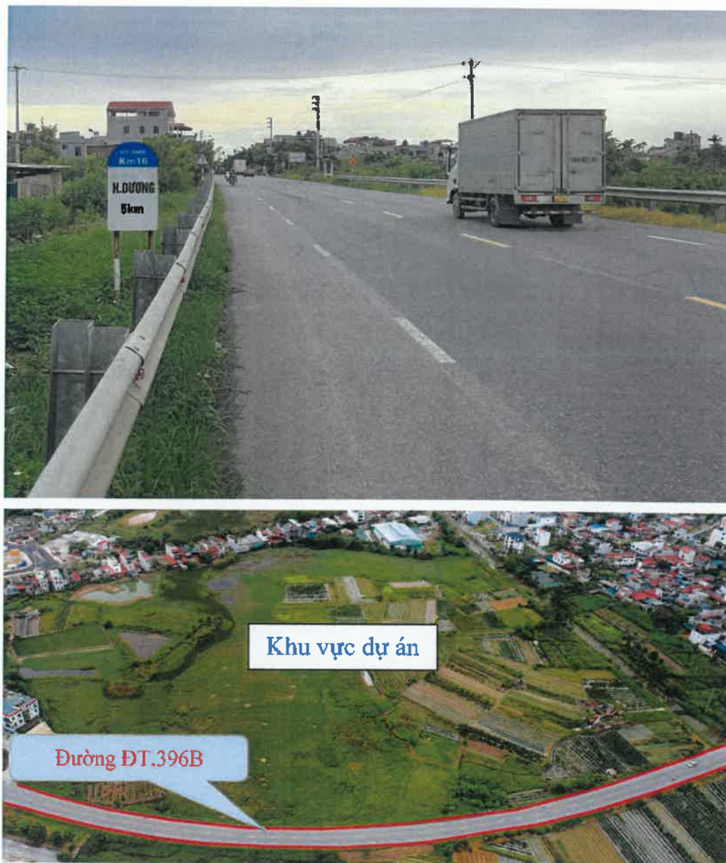
Hình 1. Hiện trạng tuyến đường ĐT.396B tiếp giáp phía Bắc dự án
