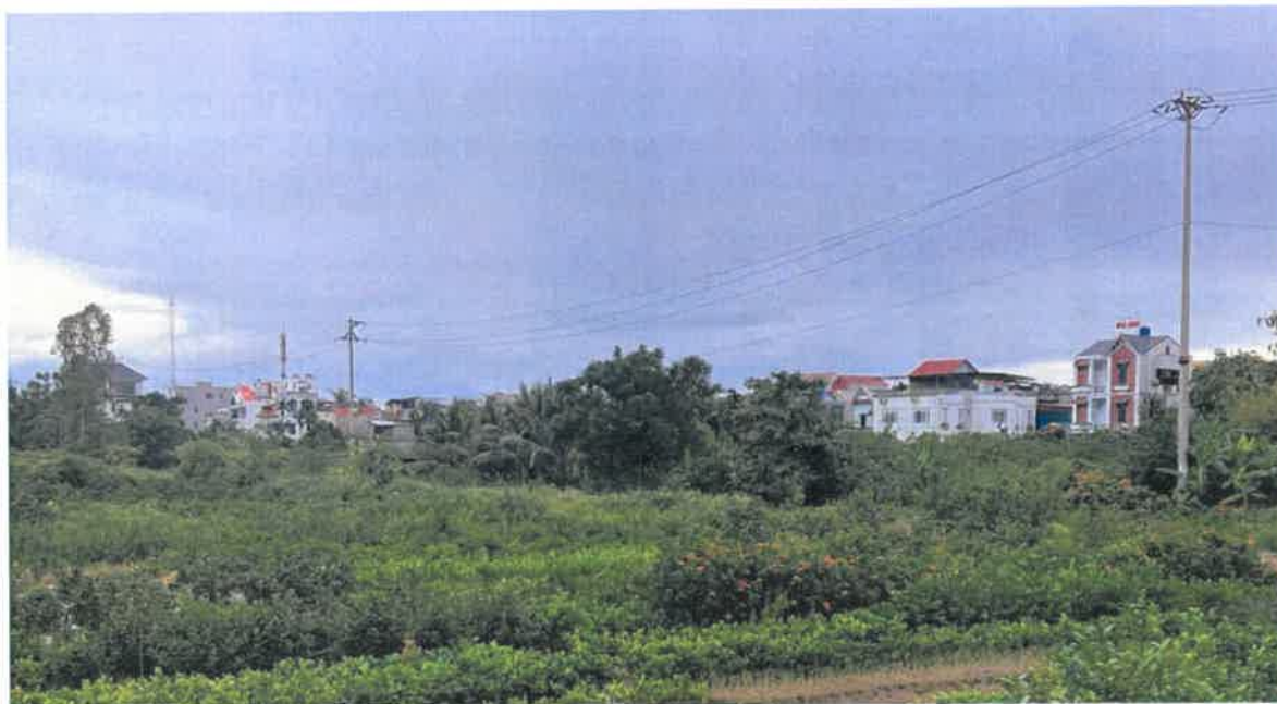
Hình 11. Tuyến đường dây điện 10kV tiếp giáp phía Tây dự án
