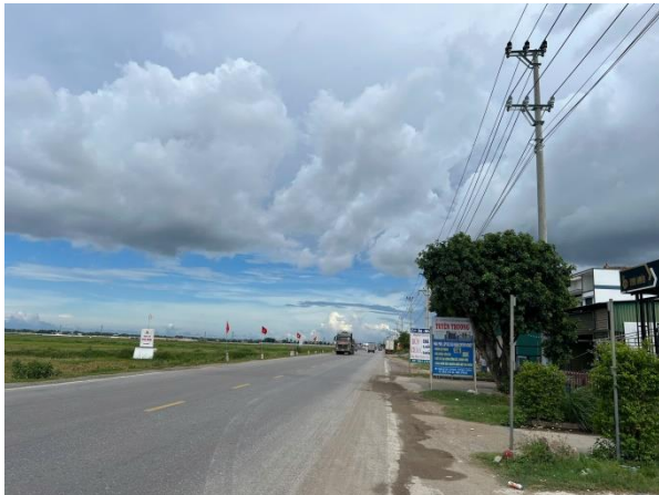
Hình ảnh đường QL 12A
