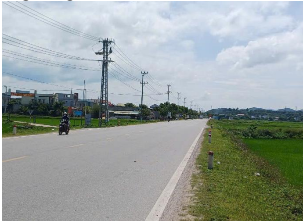
Hình ảnh đường 22kV trên Quốc lộ 12A
