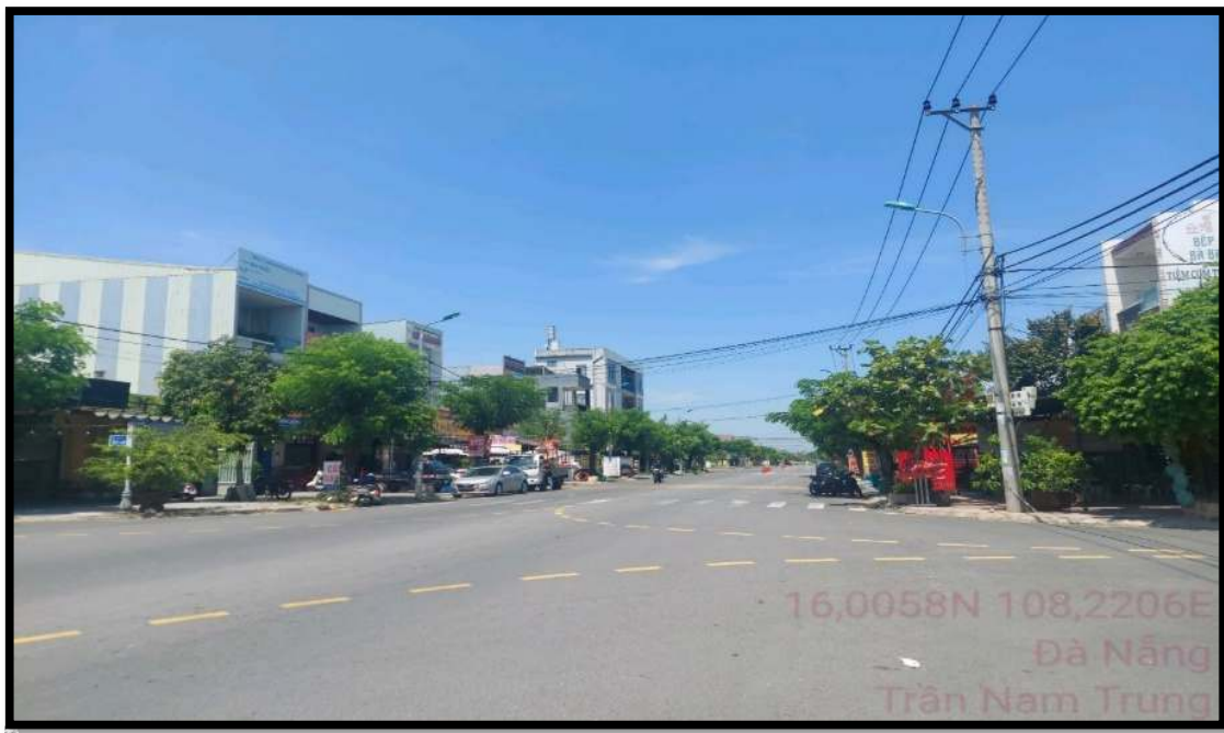
Hình 10: Tuyến chiếu sáng đi nổi đèn Sodium
