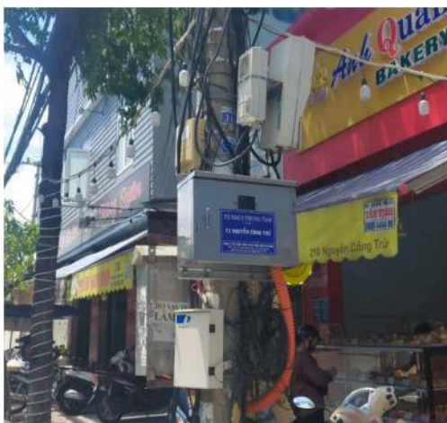
Hình 6: Tủ điều khiển chiếu sáng thông minh lắp mới tại Quận Ngũ Hành Sơn
