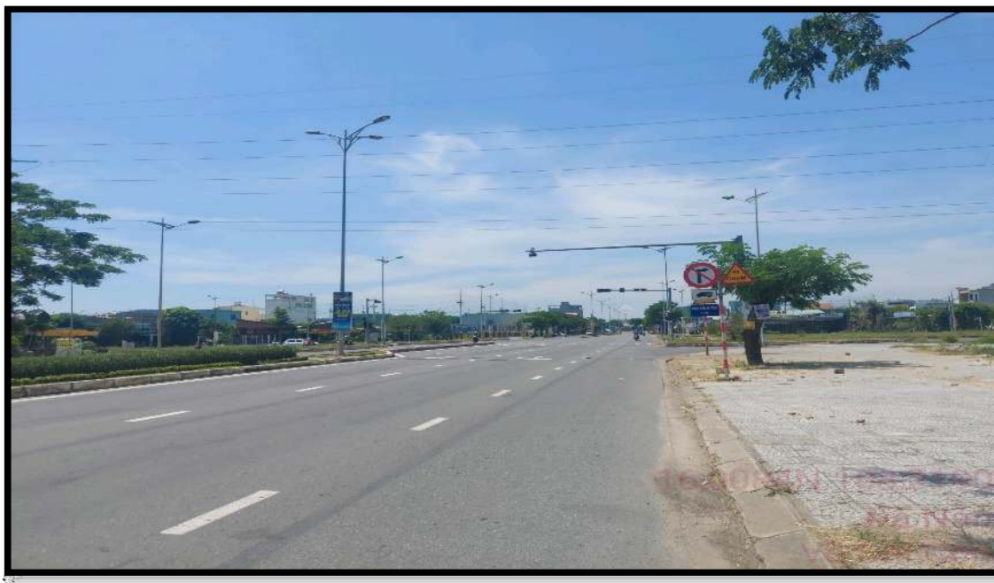
Hình 8: Tuyến chiếu sáng đi ngầm đèn Sodium
