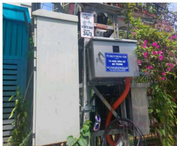
Hình 6: Tủ điều khiển chiếu sáng thông minh lắp mới tại Quận Ngũ Hành Sơn
