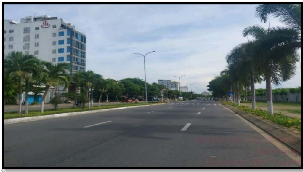
Hình 7: Tuyến chiếu sáng hiện trạng đi ngầm đèn Led
