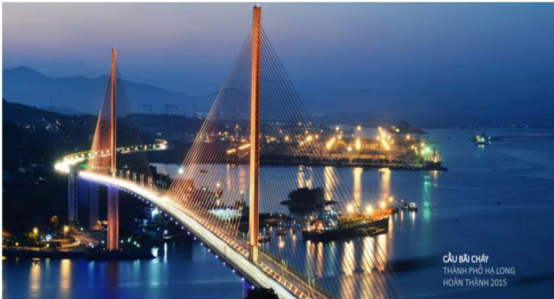
Hình 20: Cầu Bãi Cháy TP Hạ Long
