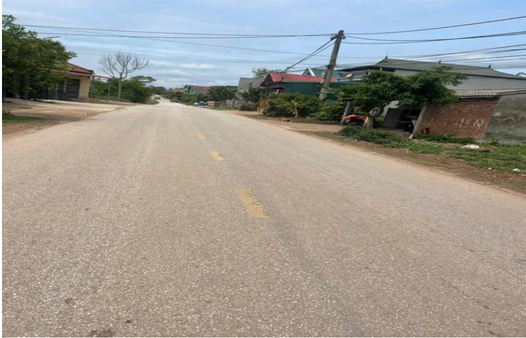
Hình 1. 4. Tỉnh lộ 237 hiện trạng
