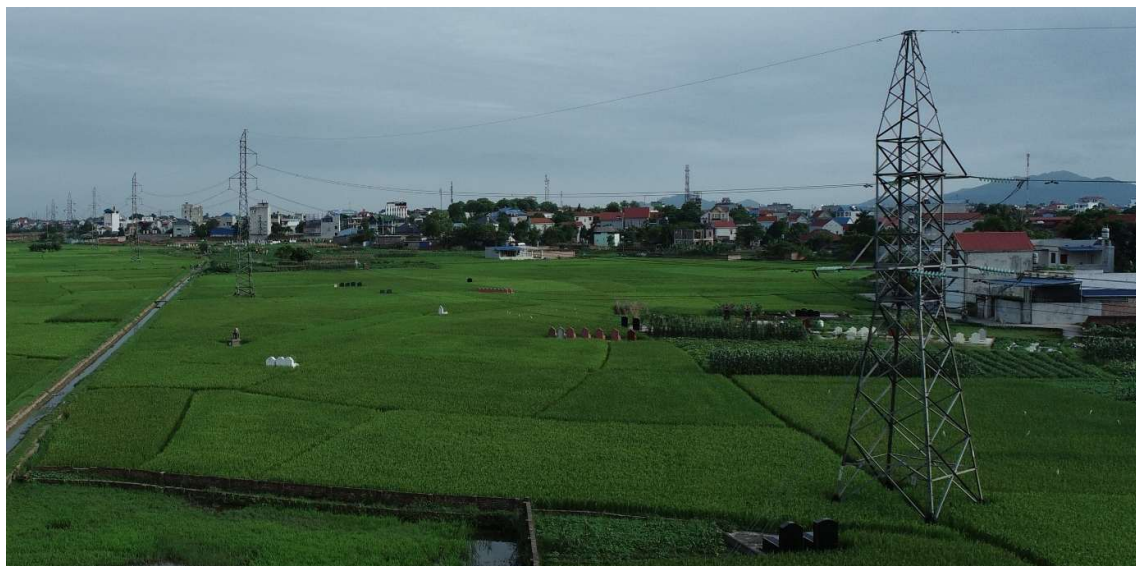
Đường điện 110KV chạy qua khu vực lập quy hoạch
