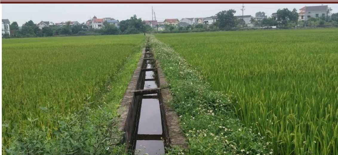
Kênh tiêu thoát nước hiện trạng
