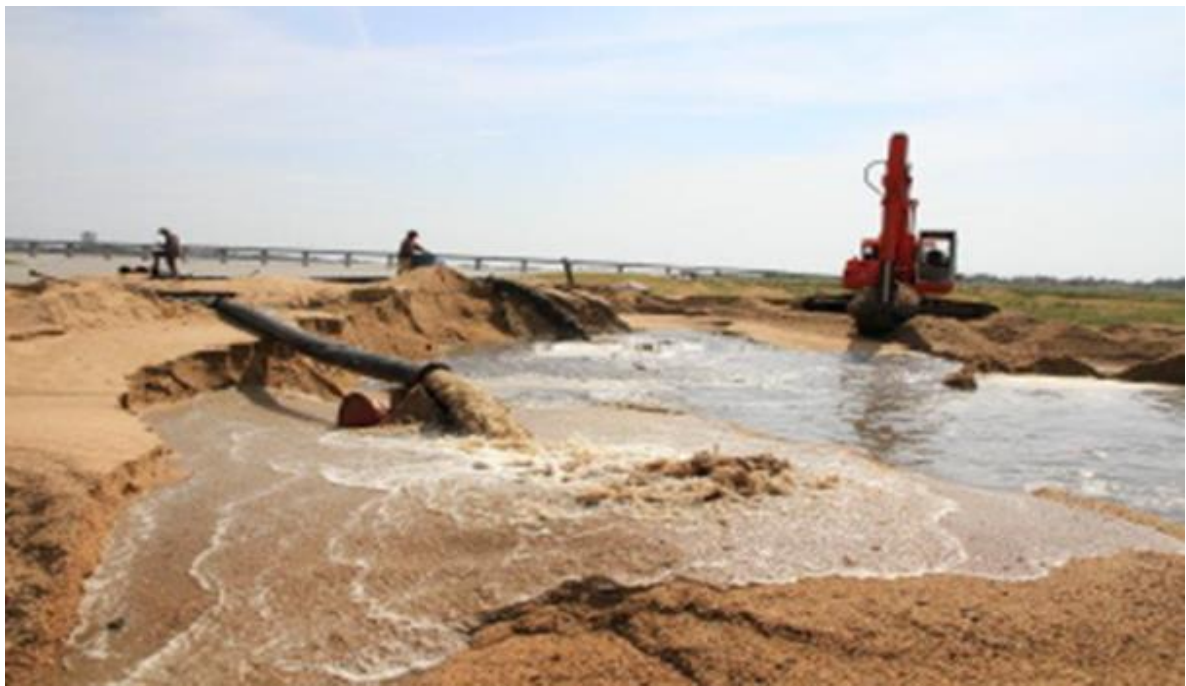
Hình 3.1. Minh họa quá trình bơm cát san lấp mặt bằng
