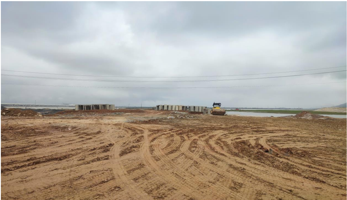
Hình 1.3. Tuyến đường Nguyễn Chí Thanh đấu nối phía Tây dự án
