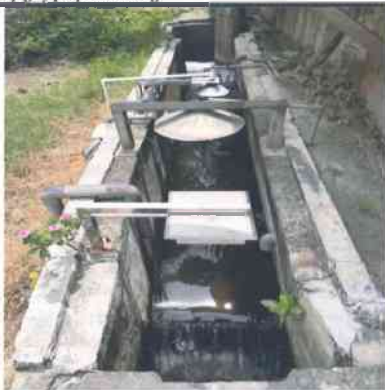
Hình 3.16. Mương quan trắc nước thải sau xử lý
