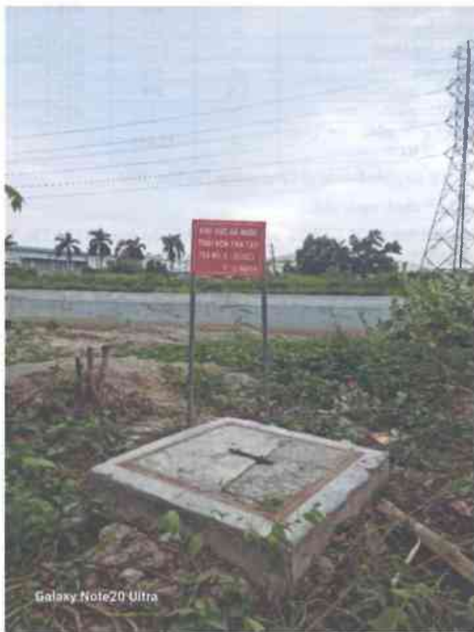
Hình 3.6. Hình ảnh minh họa hố ga đầu nối thoát nước thải sau xử lý của KCN
