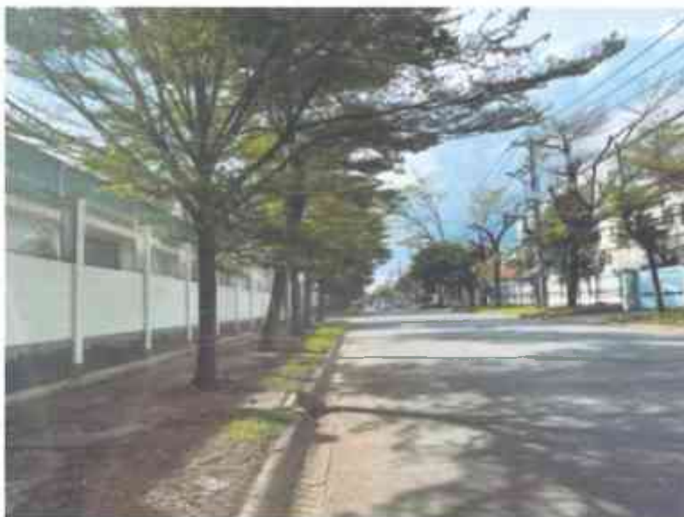
Hình 3.2. Hình ảnh minh họa hố ga thu gom nước mưa KCN
