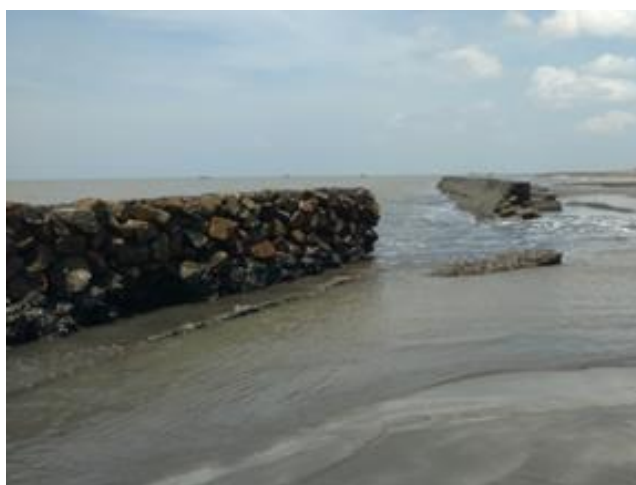
Đoạn kè chống sạt lở tại khu vực dự án
