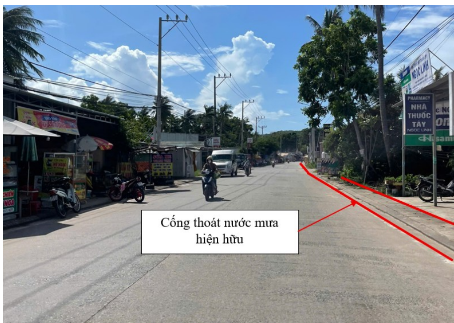
Hình 5. Hiện trạng công trình thoát nước mưa tại dự án
