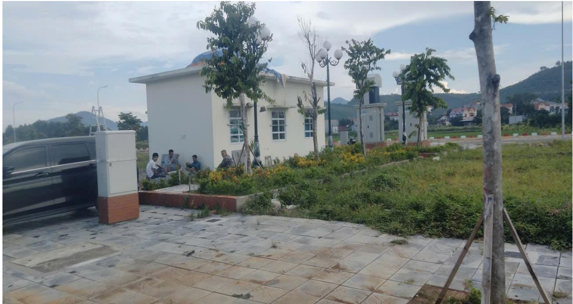
Hình 3. 4. Một số hình ảnh hiện trạng hệ thống xử lý nước thải sinh hoạt công suất 900 m 3 /ngày đêm của dự án
