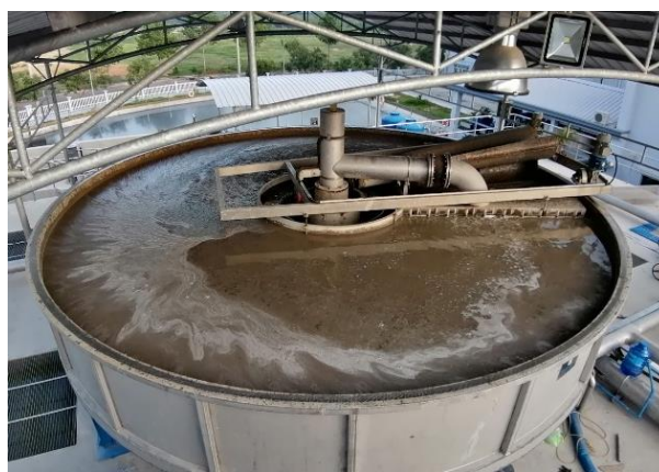
Hình 2.5. Bể tuyển nổi siêu nông (DAF)
