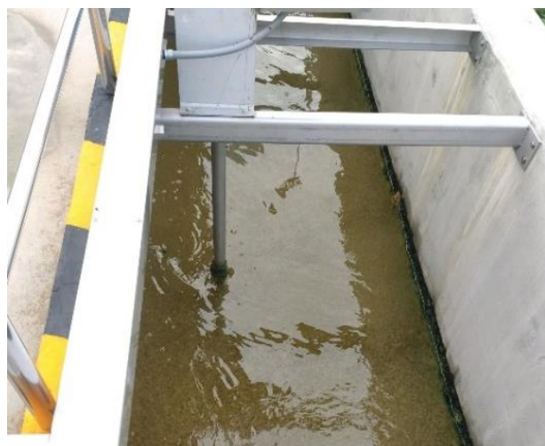
Hình 2.4 Cơ chế tạo bông và Bể tạo bông
