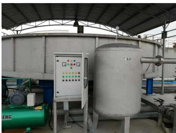
Hình 2.5. Bể tuyển nổi siêu nông (DAF)
