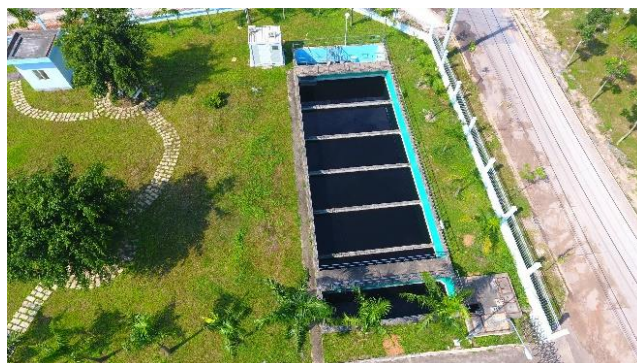
Hình 2.10. Bể khử trùng và cơ chế khử trùng (Haccpper Advantec Corp, 2020)
