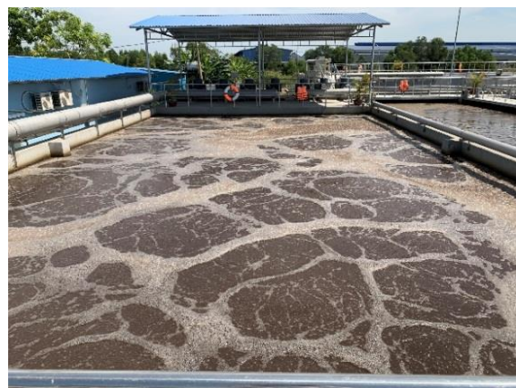
Hình 2.8. Bể Aerotank và cơ chế nitrat hóa (Nutri-Systems International, Inc, 2004)
