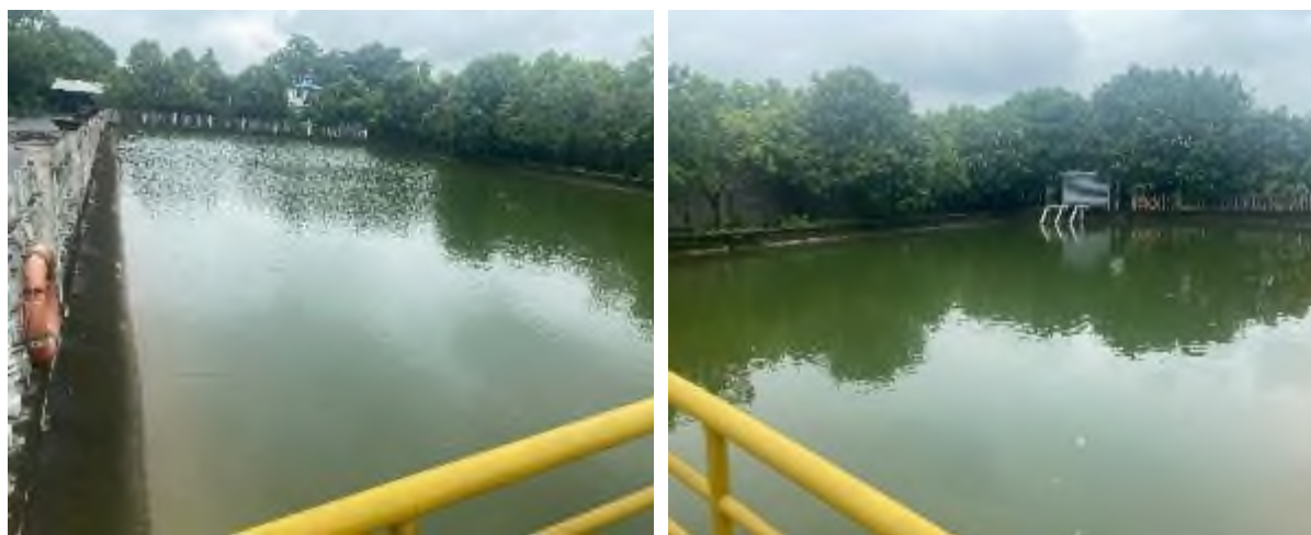
Hình 3.2: Một số hình ảnh thực tế hệ thống thu gom, thoát nước mưa của KCN Bảo Minh
