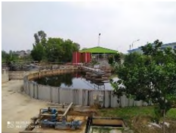
Bể lắng sinh học
