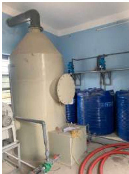
Hình 3. 19. Hệ thống xử lý mùi, khí thải đã lắp đặt
