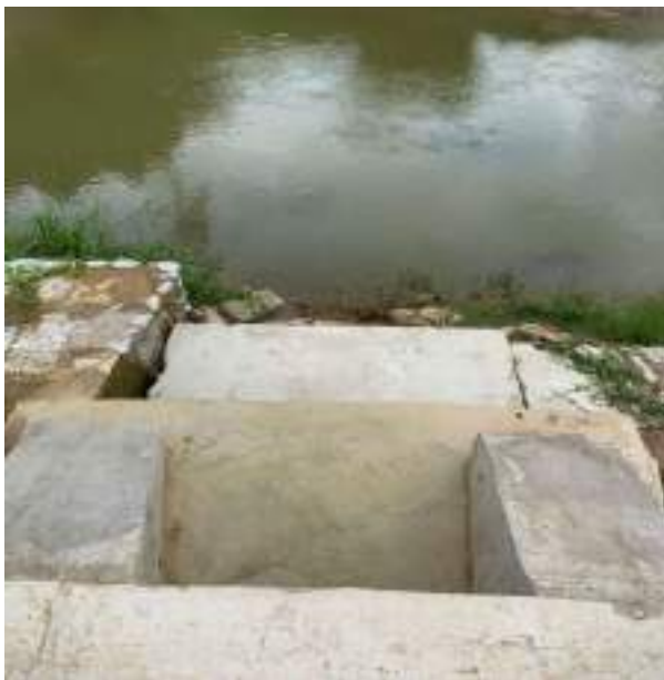
Hình 3. 6. Cửa xả nước thải của dự án ra sông Chợ Chu
