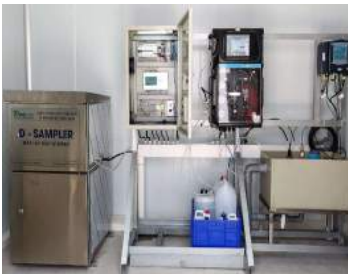
Hình 3. 16. Hình ảnh thực tế bên trong nhà trạm quan trắc tự động
