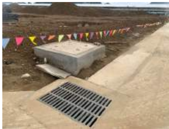
Hình 3. 2. Ga thu và cống thoát nước mưa tại dự án
