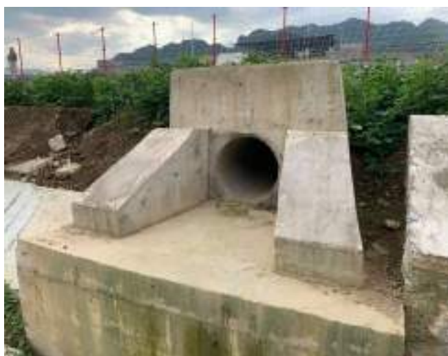
Hình 3. 4. Cửa xả nước mưa của dự án ra sông Chợ Chu
