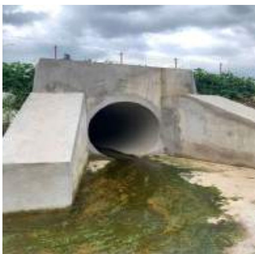
Hình 3. 4. Cửa xả nước mưa của dự án ra sông Chợ Chu
