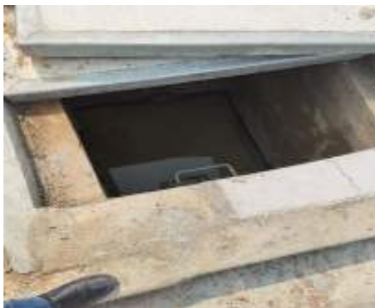
Hình 3. 2. Ga thu và cống thoát nước mưa tại dự án
