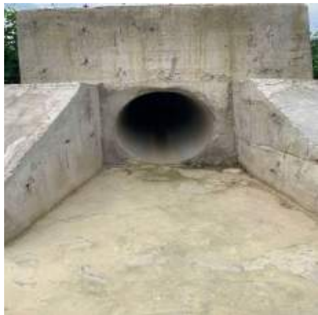
Hình 3. 6. Cửa xả nước thải của dự án ra sông Chợ Chu
