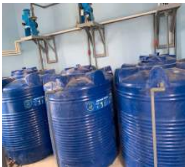
Bồn chứa hóa chất khử trùng
