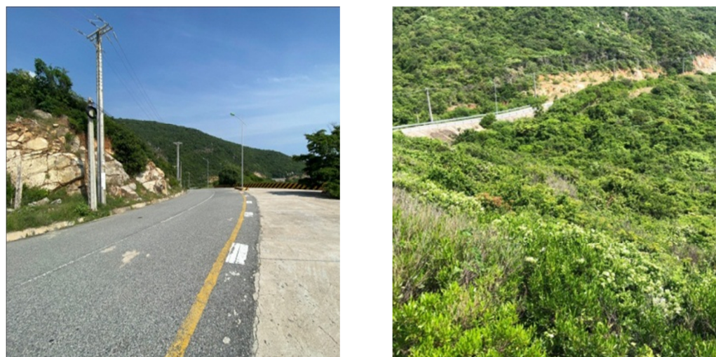
Hình 5. Hình ảnh hiện trạng tuyến đường tỉnh lộ 702
