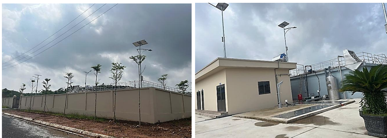
Hình 02. Trạm xử lý nước thải cụm công nghiệp
