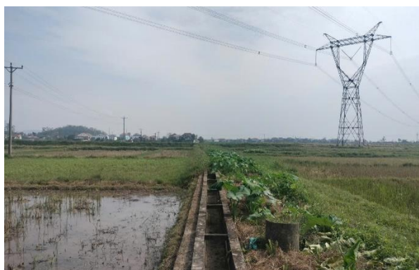
Tuyến đường dây 500kV đi dọc hành lang phía Tây Nam khu đất
