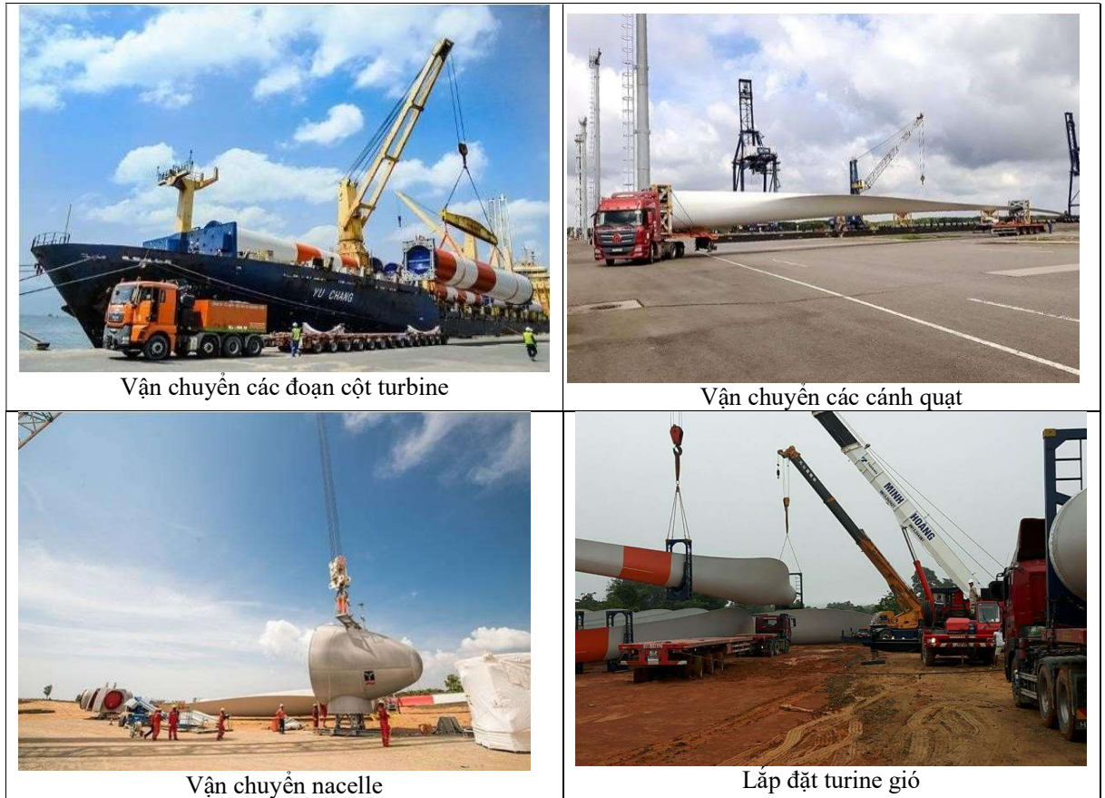
Hình 1.4. Tham khảo một số hình ảnh vận chuyển các bộ phận của turbine gió Phương án vận chuyển máy biến áp và các thiết bị điện (dây dẫn, cáp quang, cách điện, ...):
