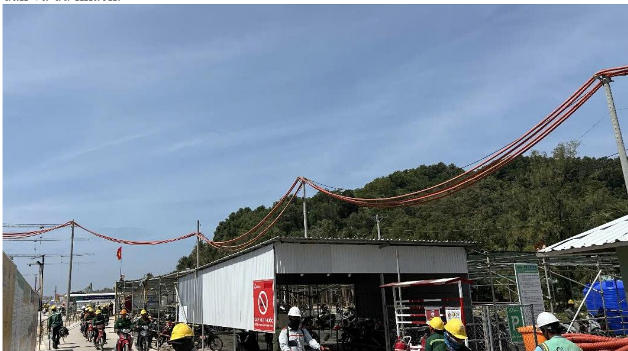
Hình 1.5. Hạ tầng kỹ thuật xung quanh khu đất Dự án
