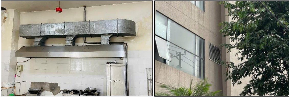
Hình 3.8. Hình ảnh hệ thống xử lý khí thải từ nhà bếp và vị trí thoát khí thải
