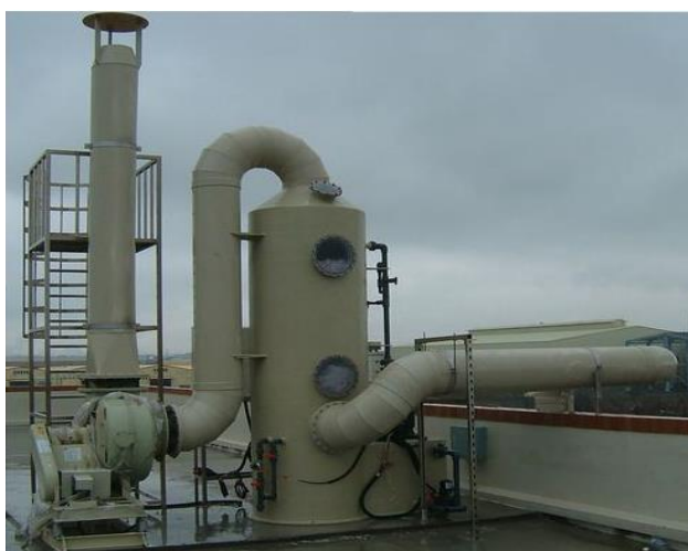
Hình 3. 4. Tháp xử lý và Cơ chế hấp thụ mùi của vật liệu hấp phụ
