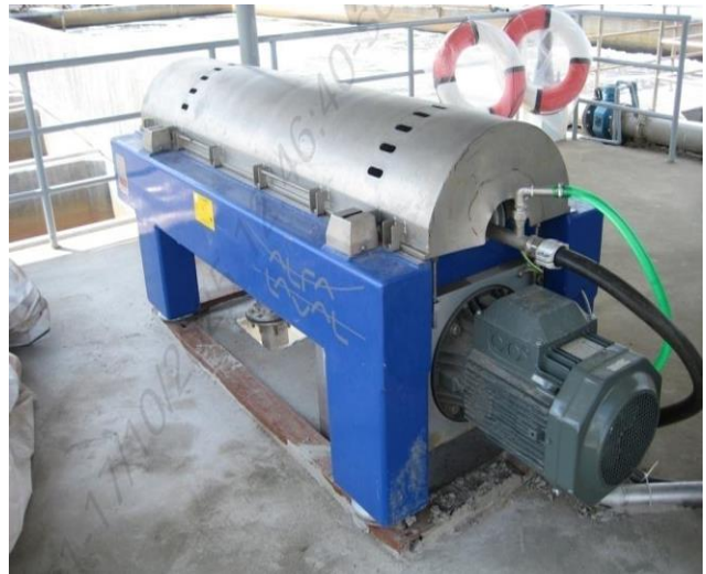
Hình 24: Nhà đặt Máy ép bùn và Máy ép bùn ly tâm
