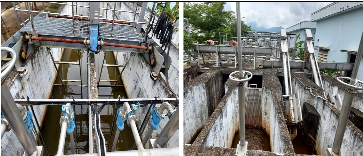
Hình 18: Bể lắng cát và thiết bị tách rác tinh
