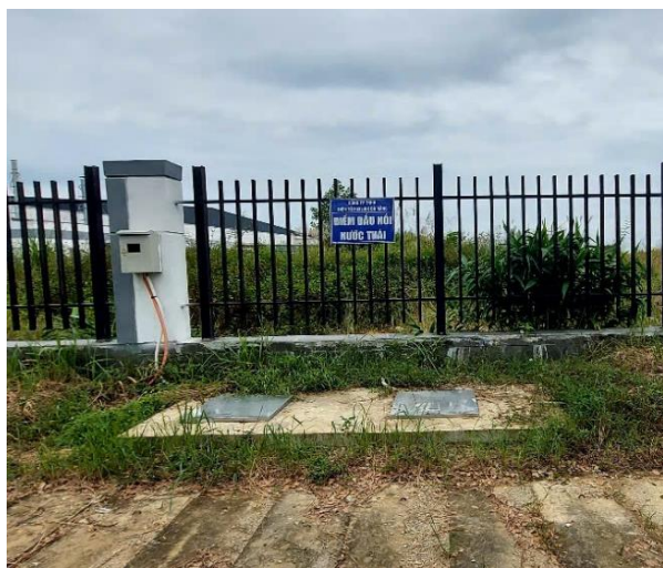
Hình 9: Một số điểm đầu nối nước thải của các đơn vị trong KCNC
