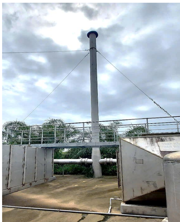
Hình 27: Hình ảnh Hệ thống xử lý mùi
