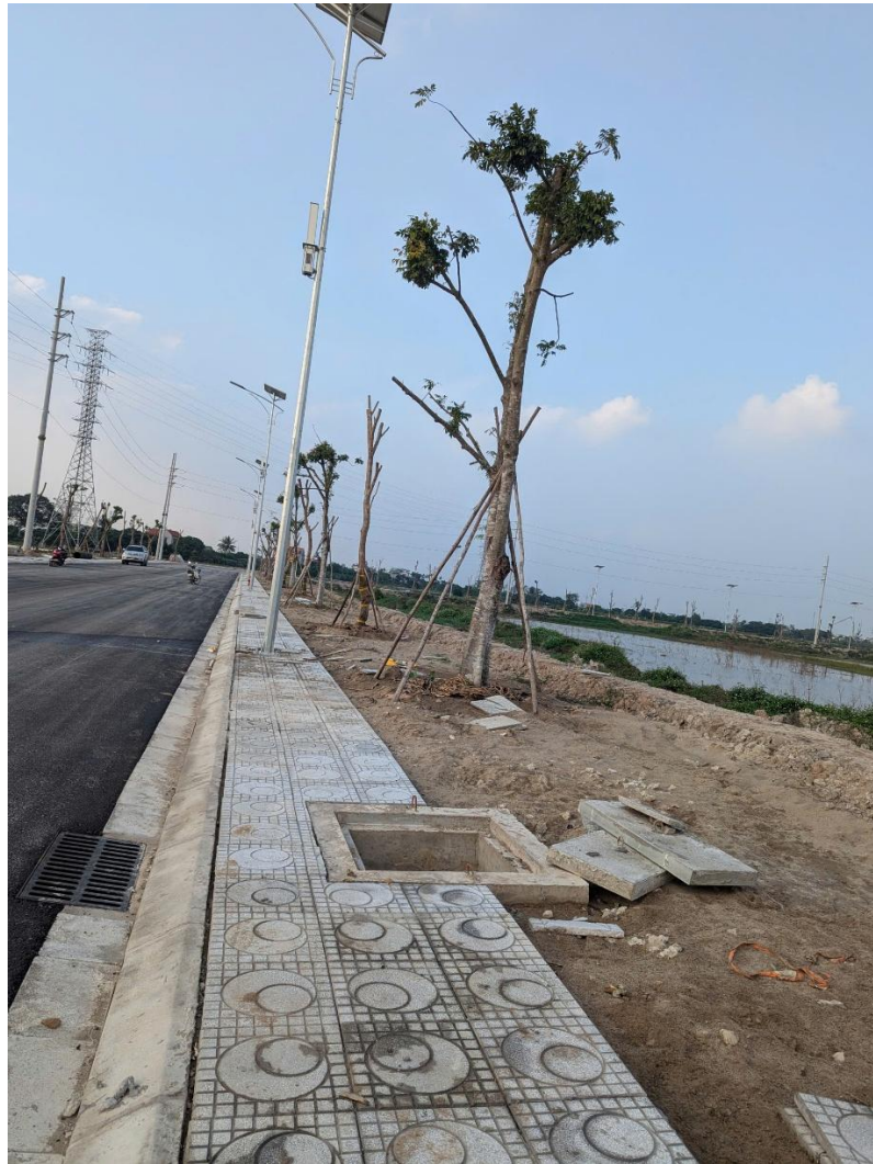
Hình 3. 3. Hệ thống thu gom nước mưa hiện hữu dự án
