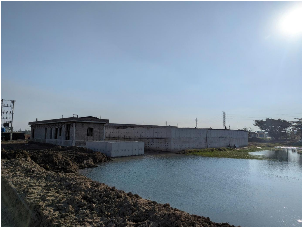
Hình 3. 7. Hệ thống xử lý nước thải tập trung hiện hữu của dự án - Thông số kỹ thuật:
