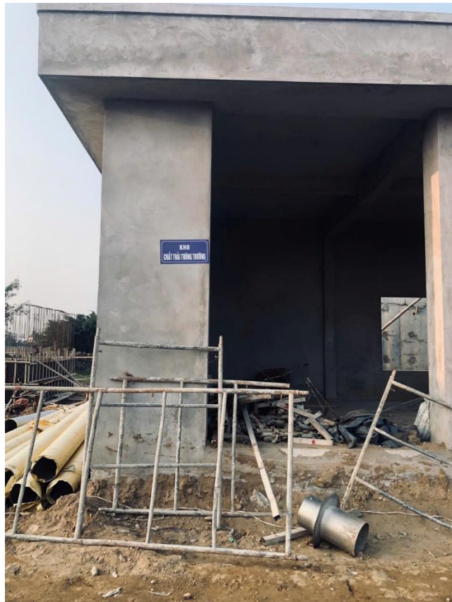
Hình 3. 8. Khu lưu giữ chất thải thông thường hiện hữu của dự án
