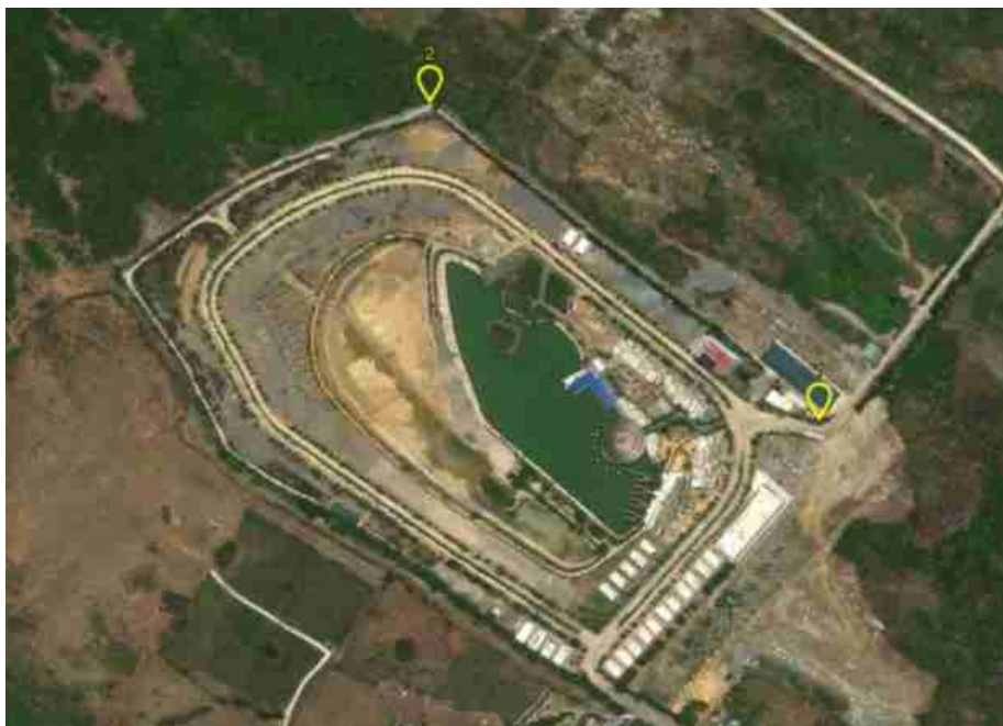
Hình 5. Vị trí 02 cửa xả nước mưa của cơ sở
