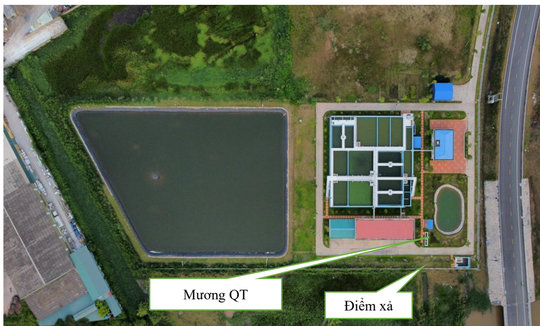
Hình 3.18: Hệ thống xử lý nước thải tập trung công suất 3.500 m 3 /ngày đêm
