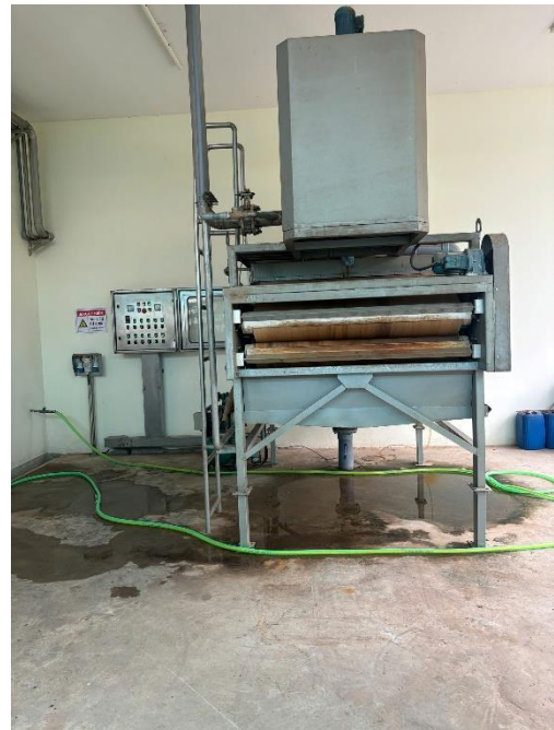
Nhà đặt máy ép bùn
