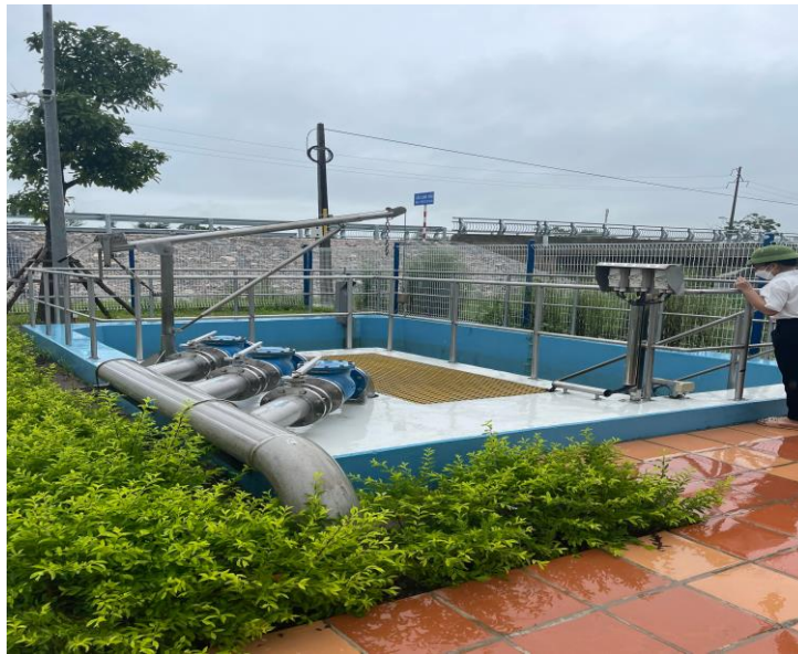
Hình 3.8: Hồ bơm nước thải
