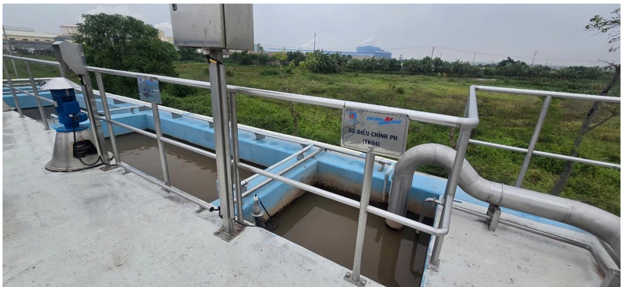
Hình 3.12: Bể điều chỉnh pH, keo tụ, tạo bông
