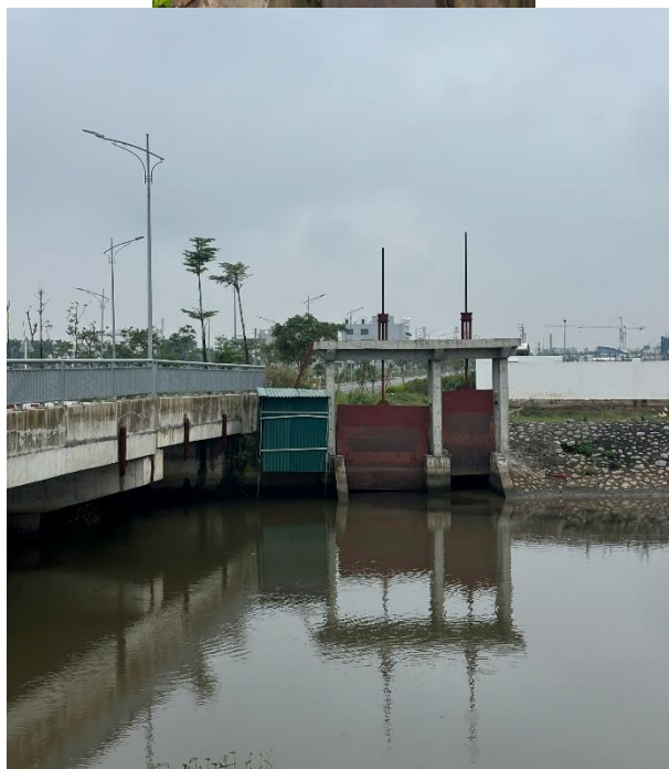
Hình 3.3: Hình ảnh tuyến mương thu gom nước mưa, cửa xả, hố thu nước mưa trong KCN Tiền Hải
