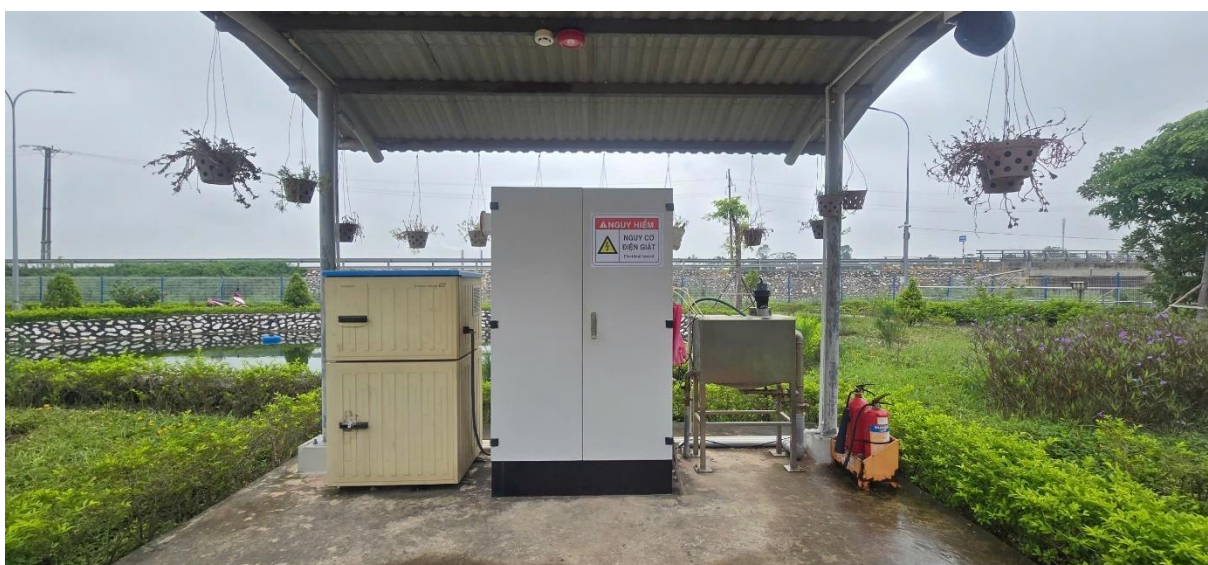
Hình 3.20: Trạm quan trắc tự động, liên tục nước thải sau xử lý của KCN Tiên Hải
