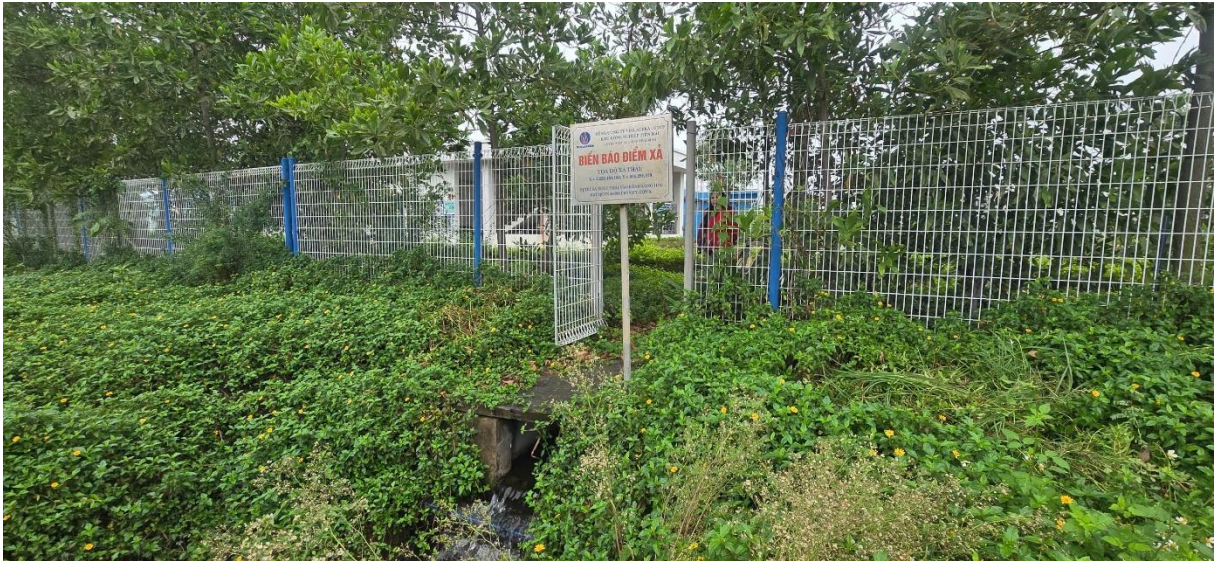
Hình 3.5: Điểm xả nước thải của trạm xử lý
