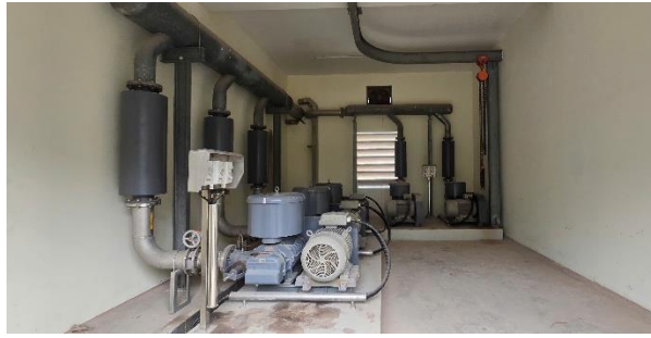
Hình 3.25: Nhà đặt máy thổi khí, nhà đặt máy phát điện dự phòng
