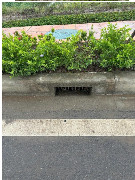
Hình 3.3: Hình ảnh tuyến mương thu gom nước mưa, cửa xả, hố thu nước mưa trong KCN Tiền Hải
