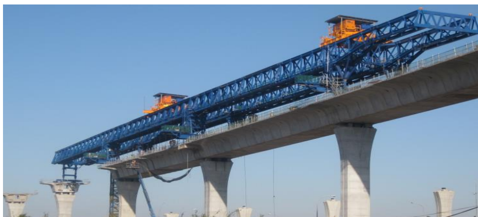
Hình 1.53. Thi công kết cấu nhịp giản đơn
