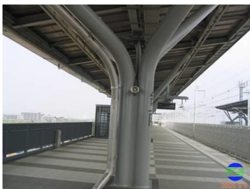
Hình ảnh: Hệ thống phát thanh tại sân ga
