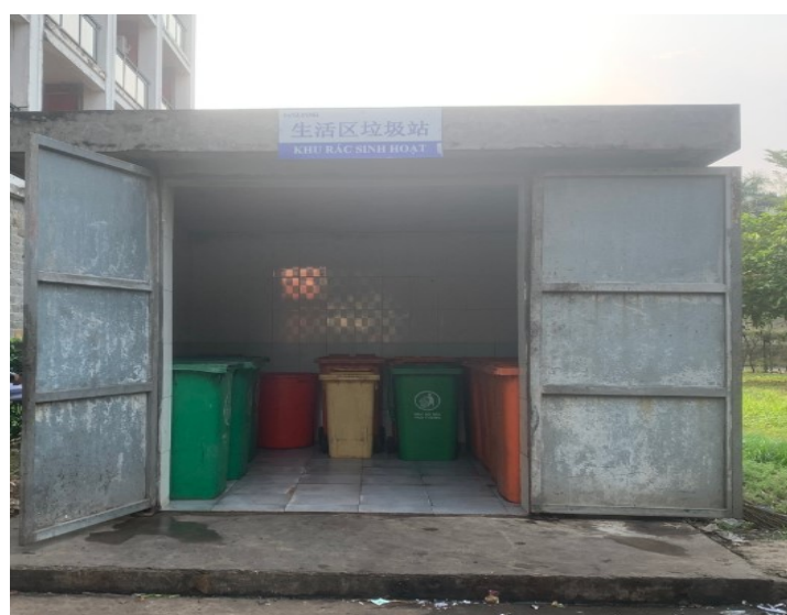
Hình 3.19. Thiết bị và kho chứa CTR sinh hoạt tại nhà máy hiện hữu
