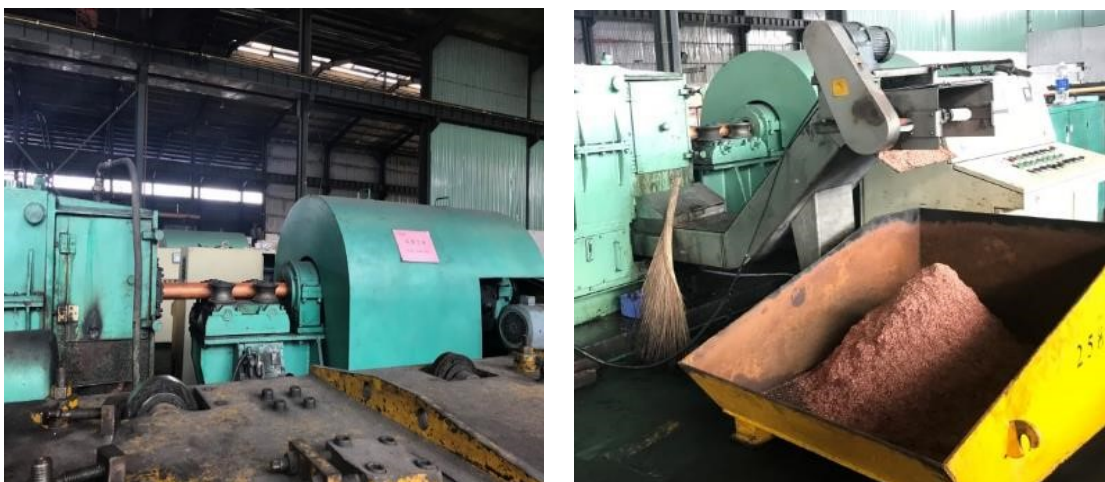
Hình 1.14. Máy bào bề mặt ống đồng tại dự án
