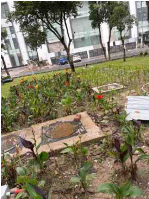
Nắp thăm các bể xử lý
