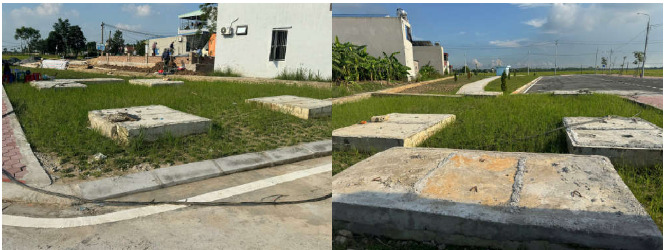
Hình ảnh hệ thống bể xử lý nước thải
