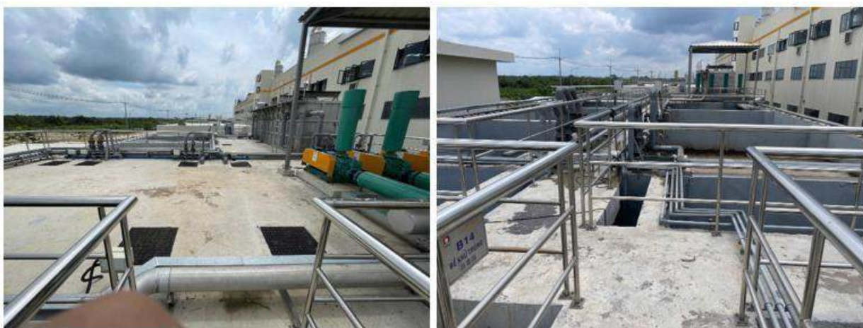
Hình 8: Dự án Tổ hợp nhà máy lắp ráp Kim Long Motor tại tỉnh Thừa Thiên Huế (nay thuộc thành phố Huế).
