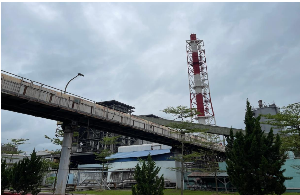
Hệ thống chuyển tải than
