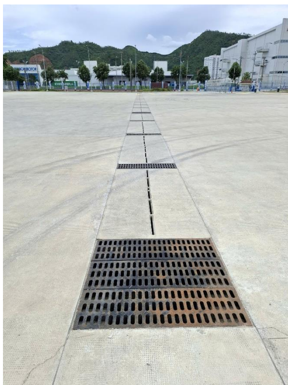
Hố ga thoát nước mưa
