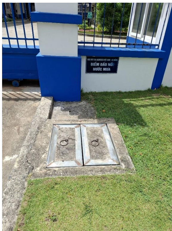
Vị trí đầu nối thoát nước mưa vào hệ thống thoát nước mưa của KCN
