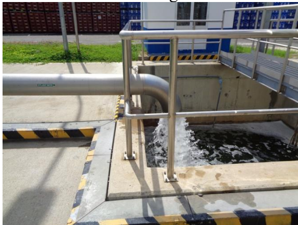
Hồ gom nước thải đầu ra
