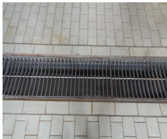
Hệ thống thu gom nước thải khu vực bên trong nhà xưởng sản xuất
