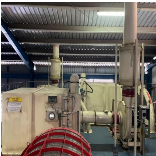
Bộ hút bụi ở hệ thống nghiền malt và gạo 08 mẻ/ngày
