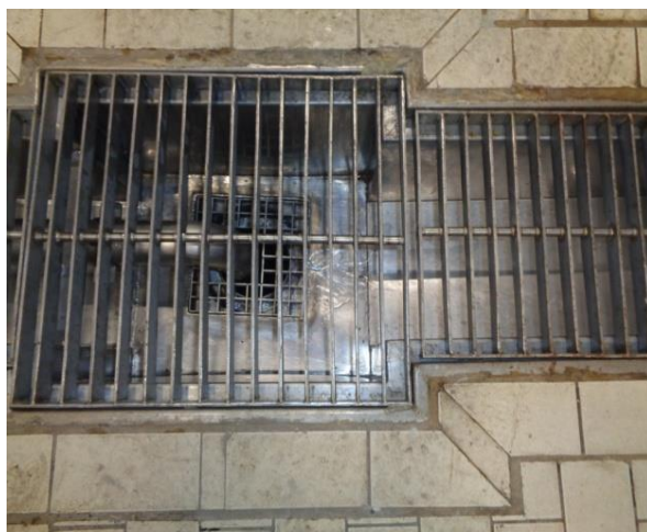
Hồ thu gom nước thải khu vực bên trong nhà xưởng sản xuất
