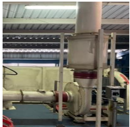
Bộ hút bụi ở hệ thống nghiền malt và gạo 08 mẻ/ngày
