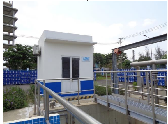
Trạm quan trắc nước thải tự động
