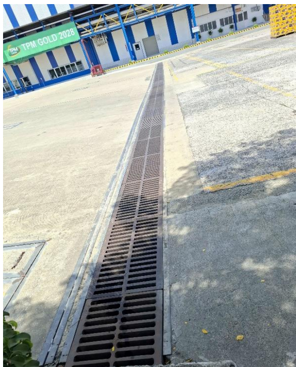
Hệ thống thu gom, máng xối thoát nước mưa
