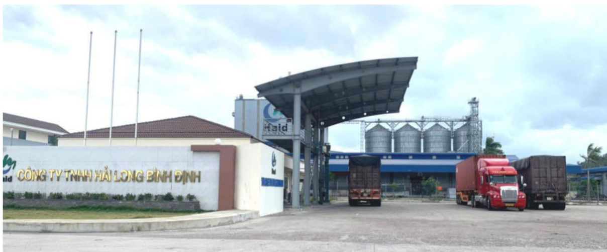
Công ty TNHH Hải Long Bình Định đã hoàn thiện thi công xây dựng
