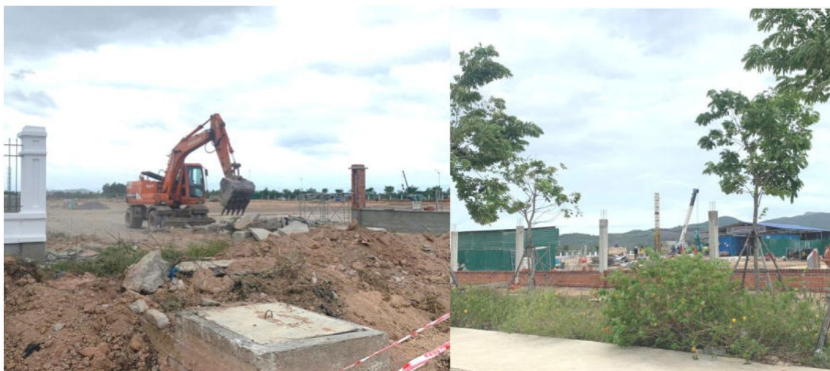
Các nhà máy đang thi công xây dựng
