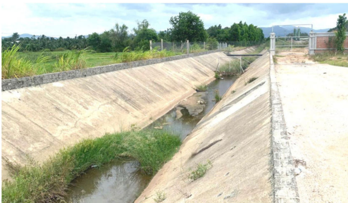
Hình 3. 15. Mương thoát nước bao quanh KCN
