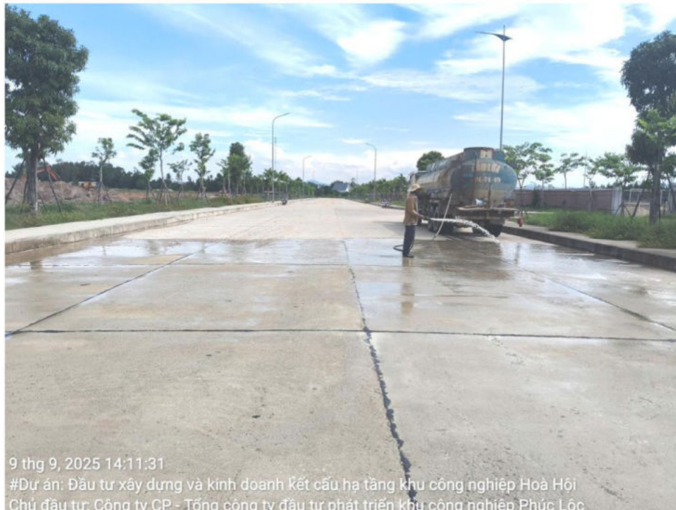
Hình 3. 20. Xe phun nước rửa đường tại KCN Hòa Hội
