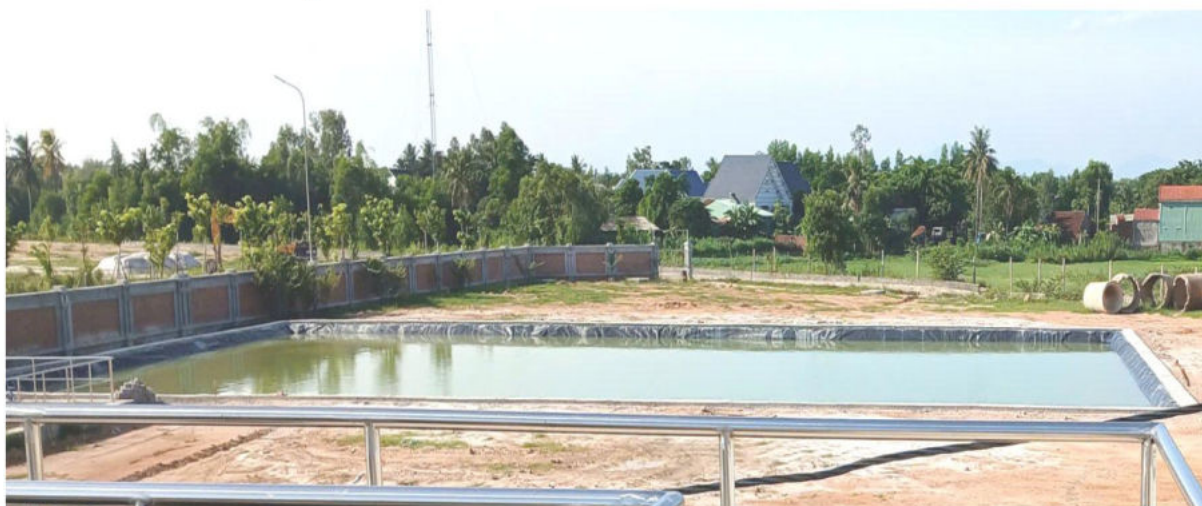
Hình 3. 19. Hồ sự cố giai đoạn 1 đã xây dựng hoàn thiện
