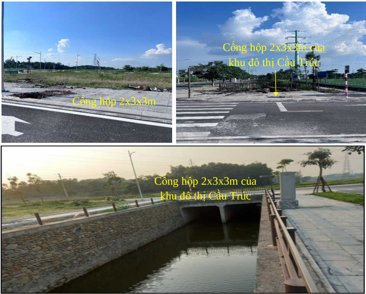
Hình 3. 3. Công tiếp nhận nước mưa của Dự án
