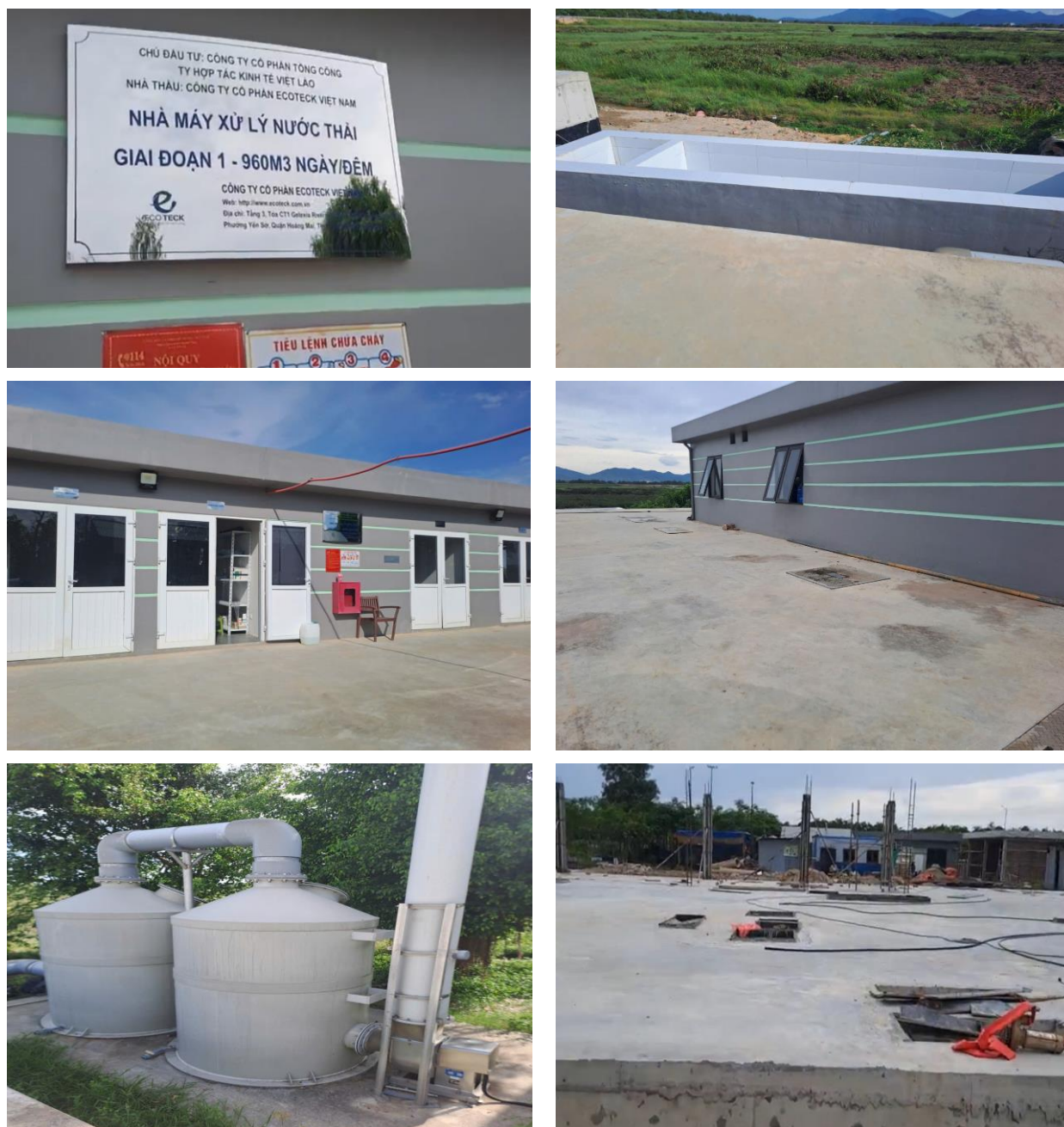
Hình 3.8. Hình ảnh thực tế của Trạm XLNT tập trung
