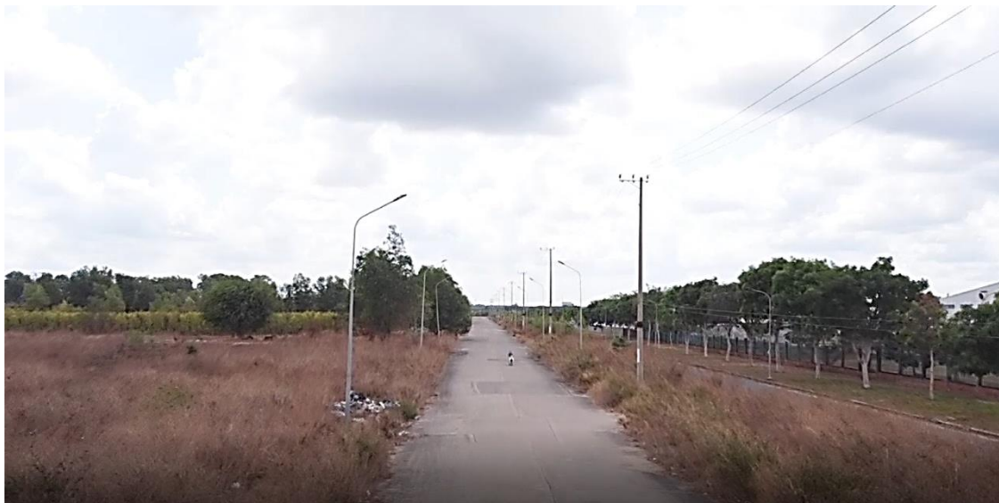
Hình 1. 8. Tuyến điện trung thế hiện hữu 22kV trên đường vào cụm CN Boomin
