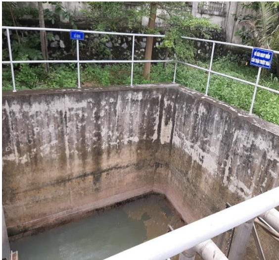
Bể thu gom
