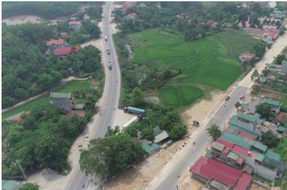
Hình 2.1: Hiện trạng cảnh quan khu vực dự án
